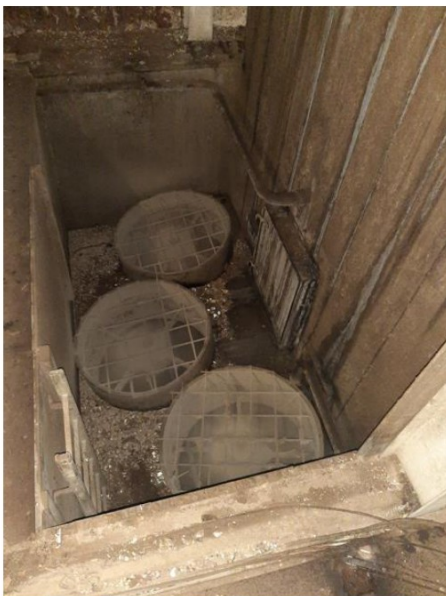
Foto B7. 8 Afzuigventilatoren gaswasser ter plaatse van B
