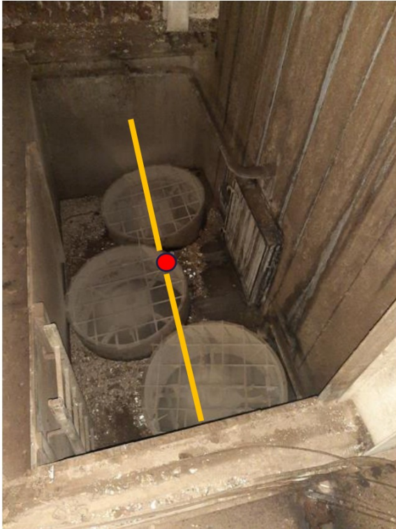
Fotoa B7.1 Afzuigkanaal boven afzuigventilatoren met plaatsing sensor (●)
