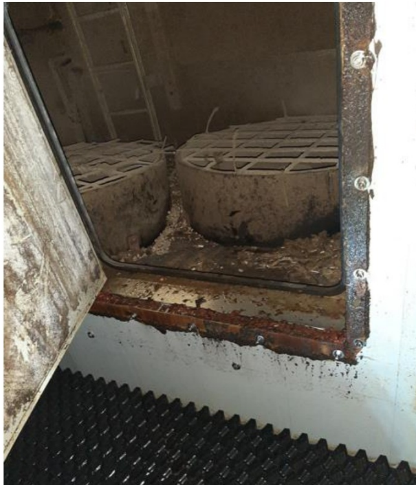
Foto B7.2 Toegangsluik na ventilatoren, filterpakket zit hierboven
