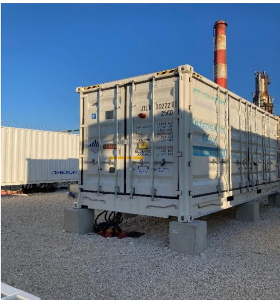
Figuur 3: Voorbeeld container BESS op verhoging
