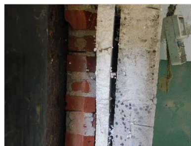
Figuur 4.9 Ruimte in spouwmuur ligboxenstal.
