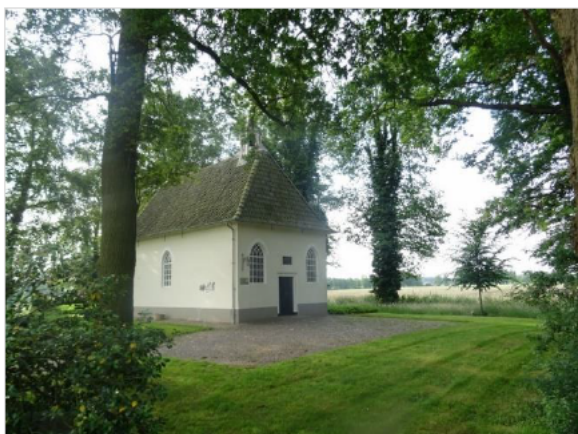
Figuur 4.5 Westelijk aanzicht van de kapel, gedekt met pannen en voorzien van dakgoten en daklood.
