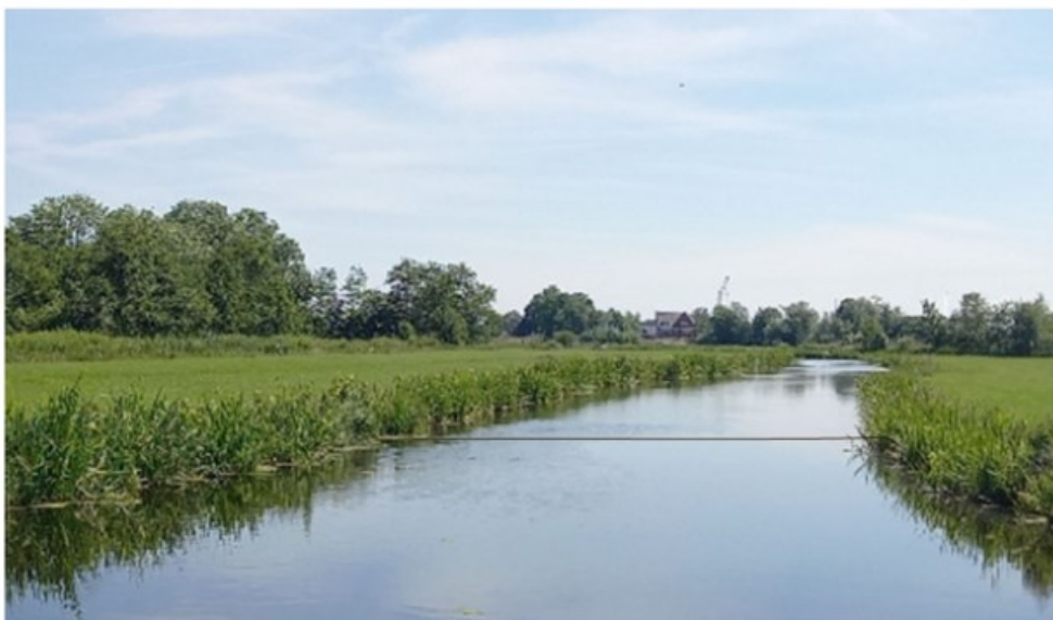
Figuur 5-2 Waterscheiding met houten damwand
