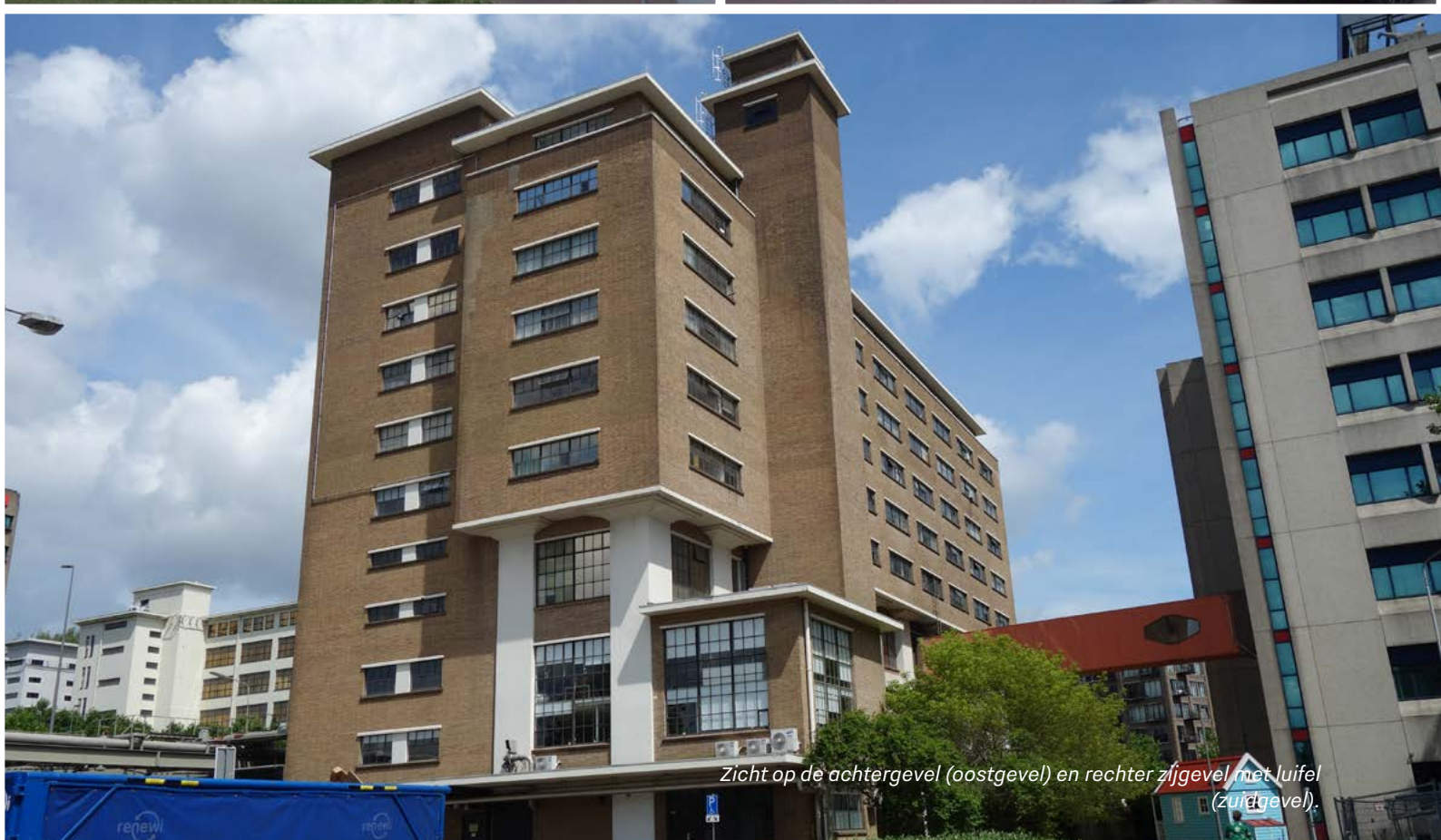
Zicht op de achtergevel (oostgevel) met hoger uitgevoerde liftschacht.
