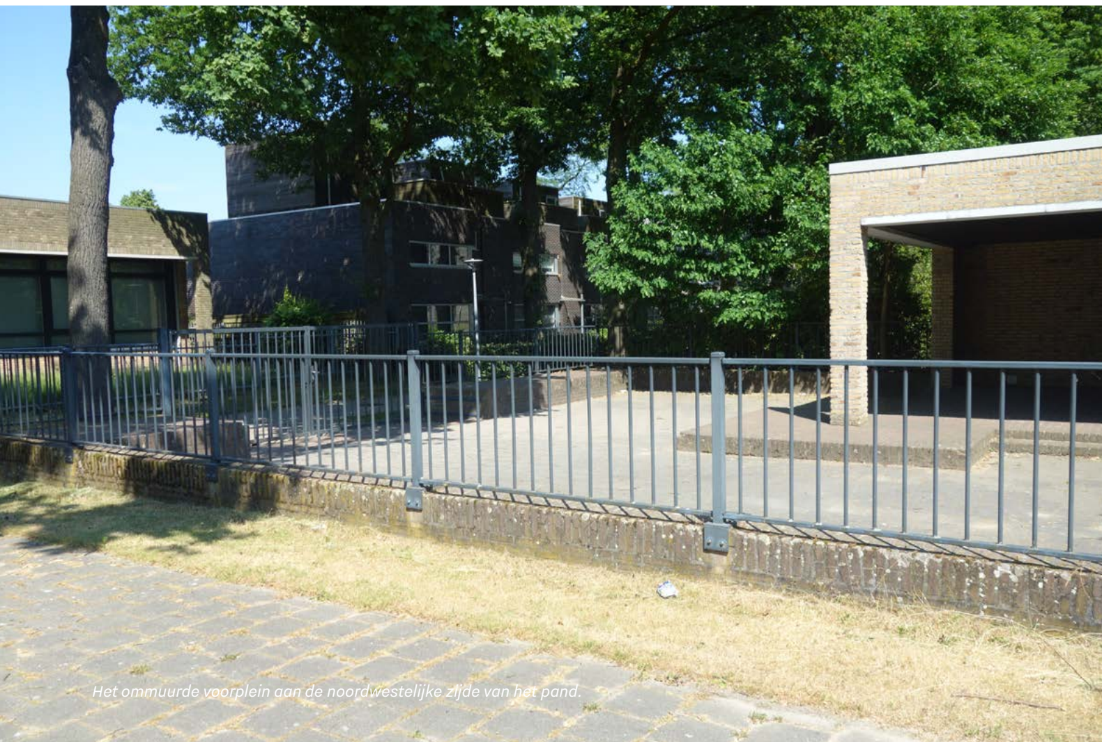
Zicht op het gebouw vanaf het Coriolanuspád (noordwestelijk van het gebouw).
