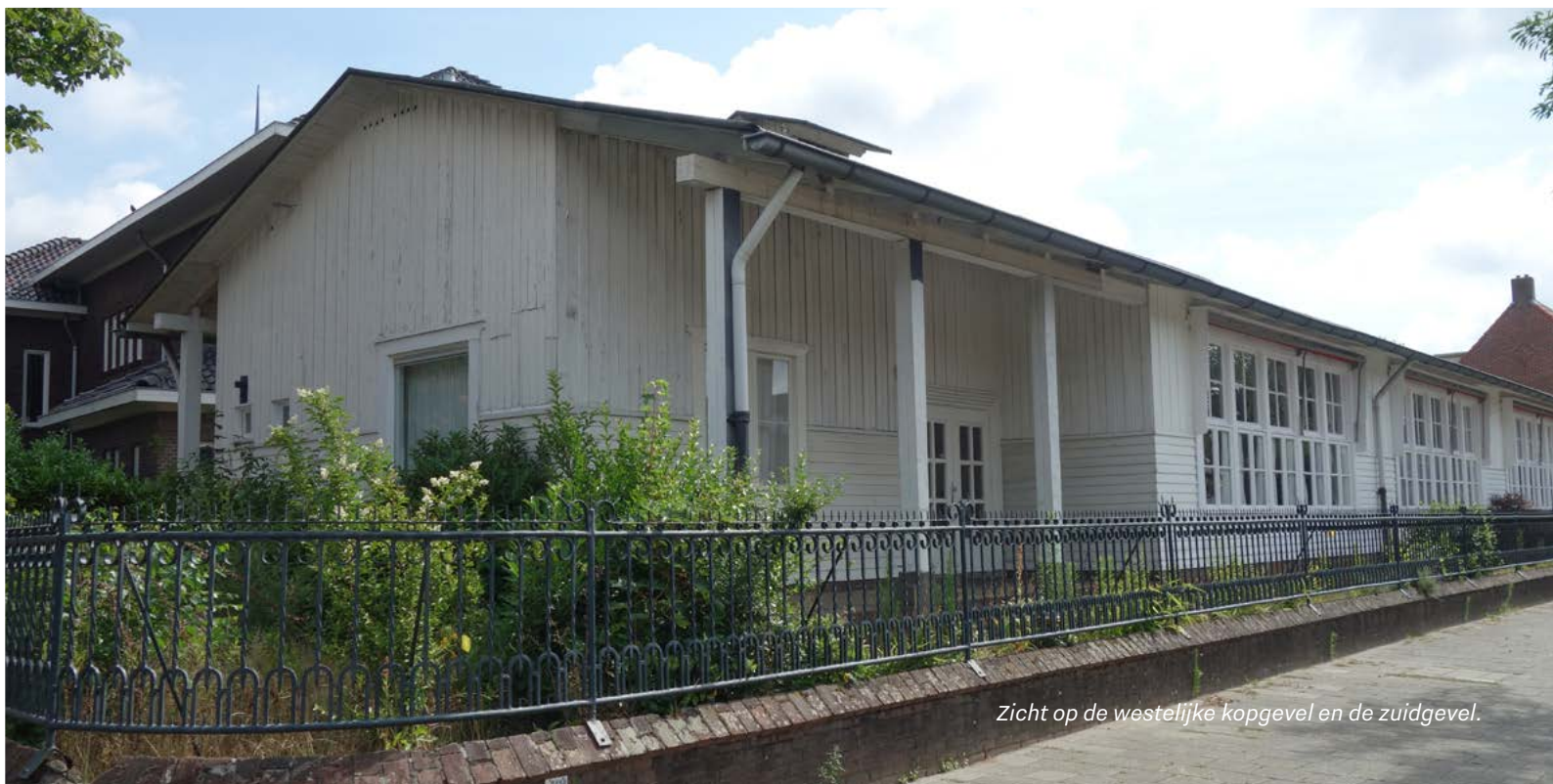
Zicht op de westelijke kopgevel en de zuidgevel.
