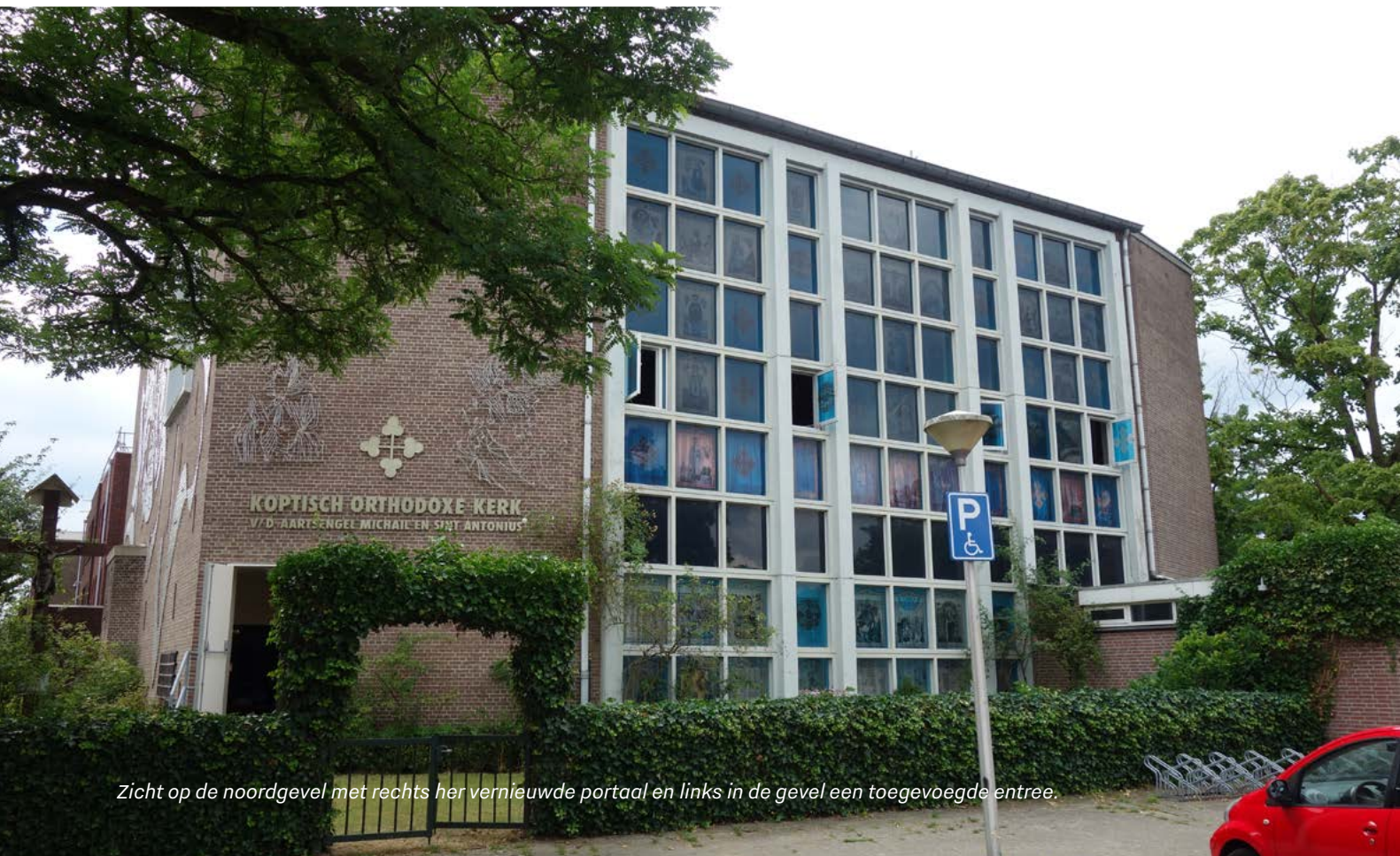
Zicht op de noordgevel met vernieuwd portaal.
