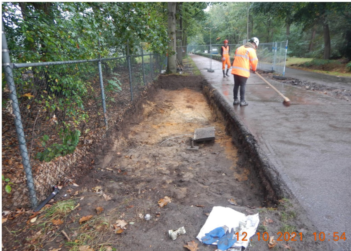
Foto 2: putbodem 1, rechts putwand 4 onder fietspad. Foto richting: west
