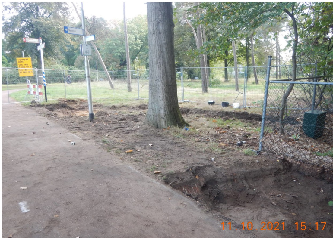
Foto 1: te handhaven boom. Voorgrond: putbodem 1, putwand 3. Achtergrond: putbodem 2. Foto richting: zuidoost
