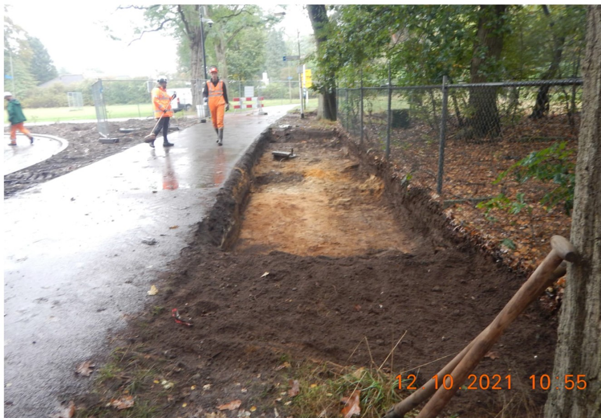
Foto 3: putbodem 1, links putwand 4 onder fietspad. Foto richting: oost
