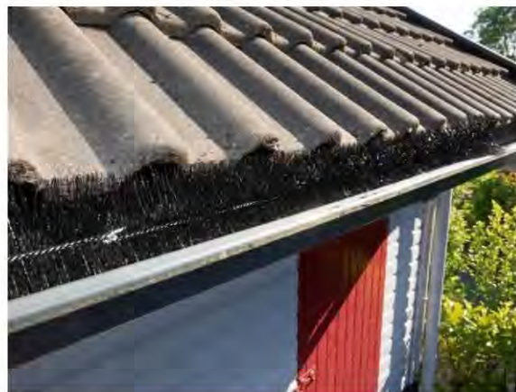
Figuur 8.6 Voorbeeld van toepassen spouwborstels in dakgoot.
