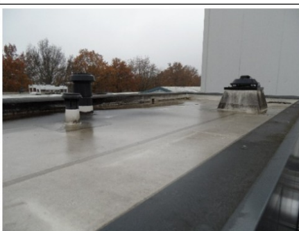
Ventilator met Lw van 54 dB(A) - niet relevant
