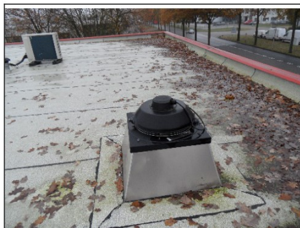
Ventilator met Lw van 54 dB(A) - niet relevant
