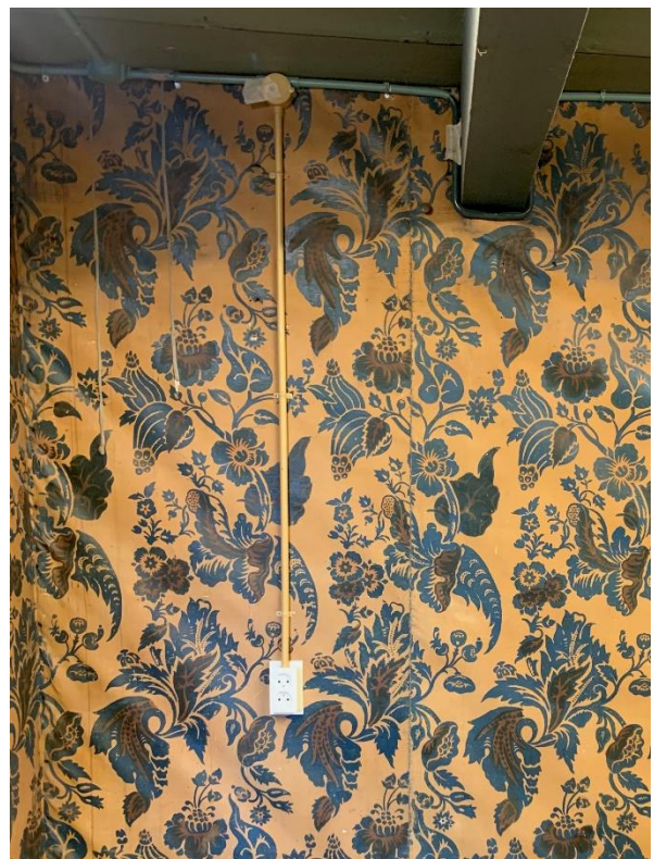
Op het behang bevestigde kabelgoot
