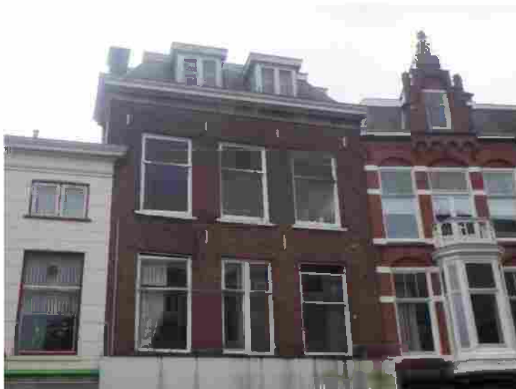
Afbeelding 38 Originele vensters op de tweede verdieping Scheveningseveer 17-19 zijn niet meer aanwezig. Foto: Vestigia 21-11-23.
