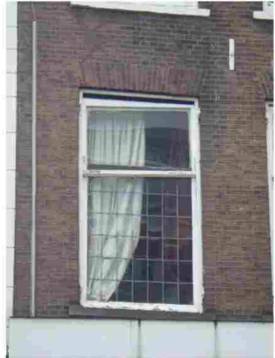
Afbeelding 34 Ramen aan de linkerkant van Scheveningseveer 17-19 'hangen' scheef. Foto: Vestigia 21-11-23.
