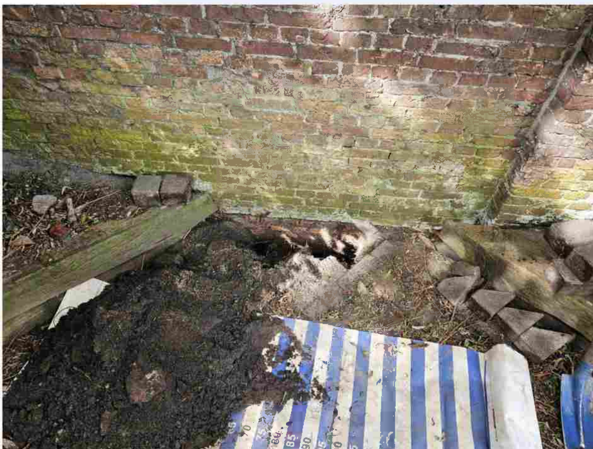
Foto 9: proefsleuf 1, tussen boomnummer 1 en 2 om diepte fundatie muur te bepalen
