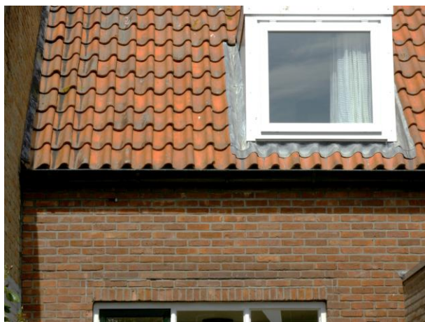
Figuur 5.6: Ruimte onder eerste rij dakpannen is dichtgemaakt.
