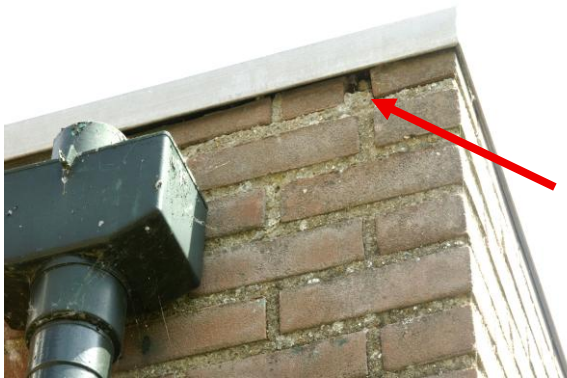
Figuur 5.3: Gat onder dakrand (rode pijl) geeft geen toegang tot spouwmuur
