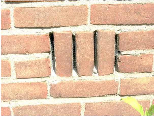
Figuren 5.1 en 5.2: Open stootvoegen en roosters zijn dichtgemaakt met bijenbekjes.
