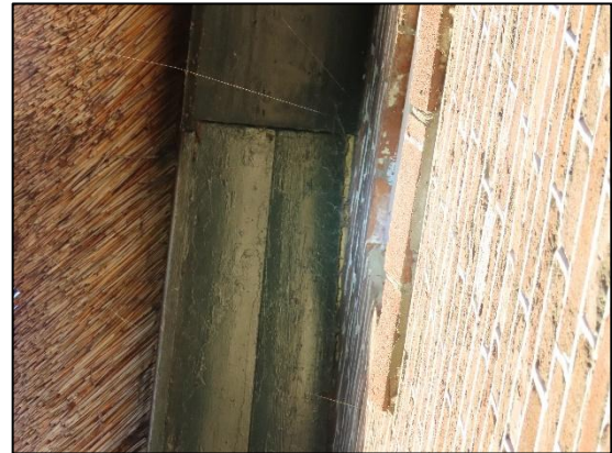
Fig. 2.24, Spleet tussen muur en dakoverstek van gebouw 3 (bron: FF Solutions)
