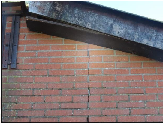
Fig. 2.45, Kapot dakoverstek van gebouw 9 en spleet in muur (bron: FF Solutions)
