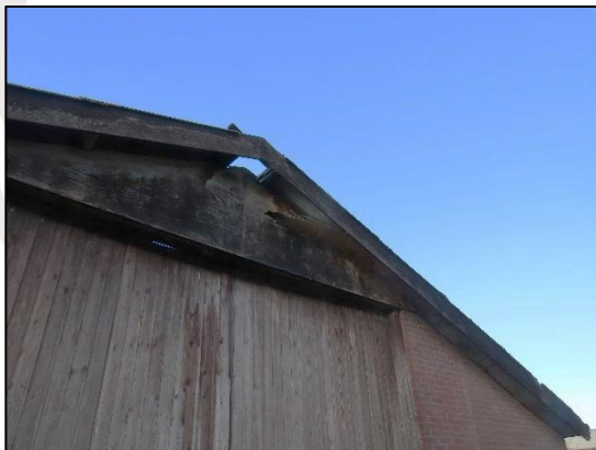
Fig. 2.43, Kapot dakoverstek van gebouw 9 (bron: FF Solutions)
