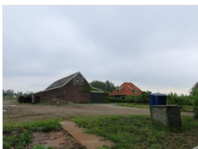
Figuur 2.9 Overzichtsfoto van de schuur en de woningen (kijkrichting: oost).
