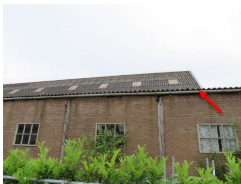
Figuur 4.18 Ruimte tussen de muur en de dakplaten (aangegeven met de rode pijl).
