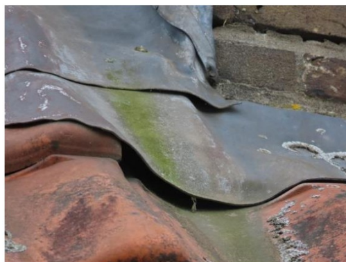
Figuur 4.14 Ruimte onder flappen bij de woningen.
