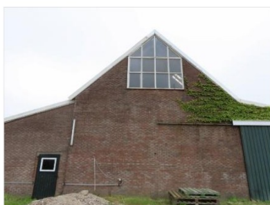
Figuur 2.10 Vooraanzicht van de schuur (kijkrichting: noordoost).
