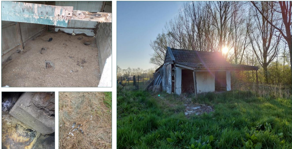
Figuur 3.2 Linksboven: vergraven zand en holen in de kleine schuur, linksonder: sporen als prooiresten, rechts: weergave van de kleine schuur.
