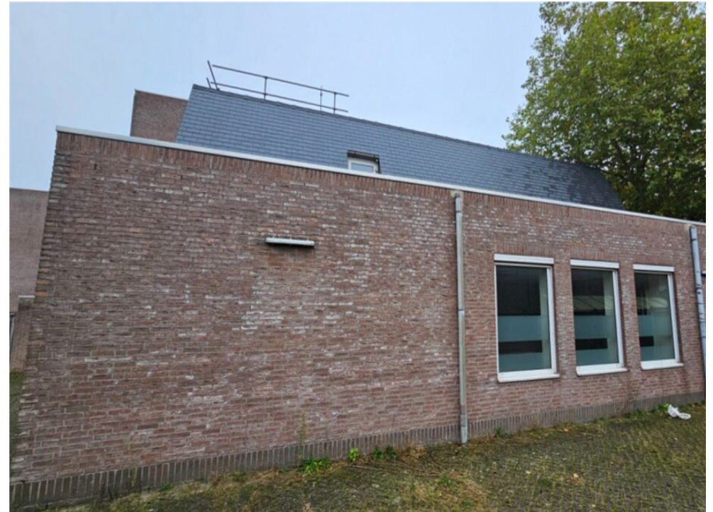
Afbeelding 4. Beeld van de linker gevel (zuidzijde).
