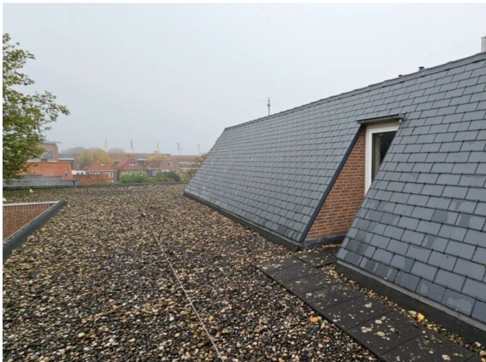
Afbeelding 6. Beeld van het grinddak.
