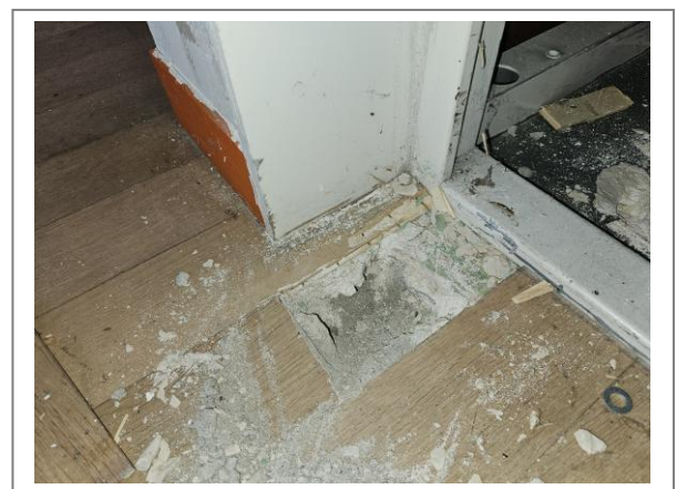
Destructief onderzoek parketvloer begane grond
