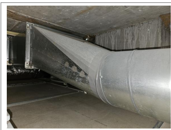
Ruimte boven systeemplafonds
