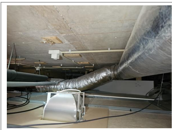
Ruimte boven systeemplafonds
