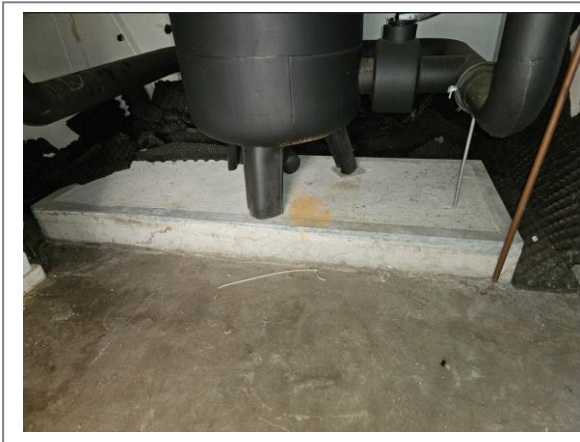
Betonnen opstorting onder installatie
