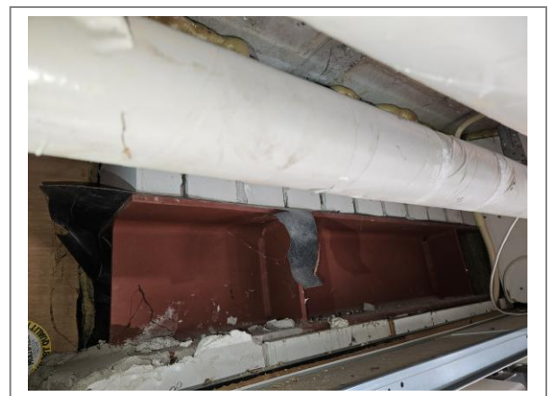
Ruimte boven systeemplafonds
