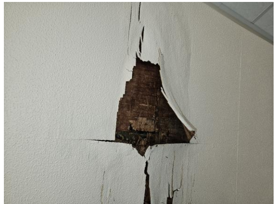
Onderzijde dakpakket v.v. houten aftimmering
