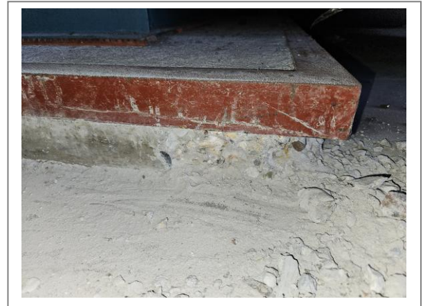
Destructief onderzoek betonopstorting
