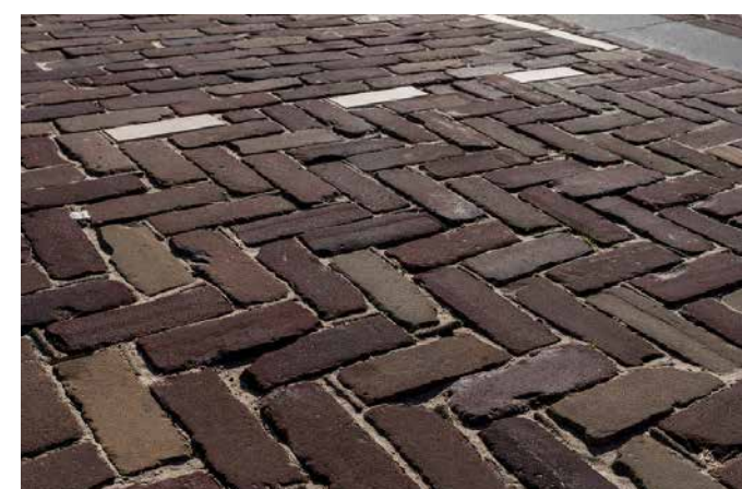
Markering met contrasterende steen om afval ophaallocatie aan te geven
