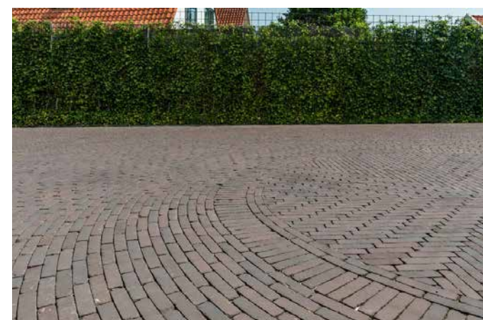
Markering van de terrassen met rollaag en ander verband
