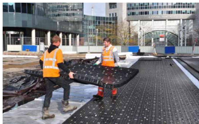
Referentiebeeld aanleg retentiekragen systeem onder Orlyplein Amsterdam
