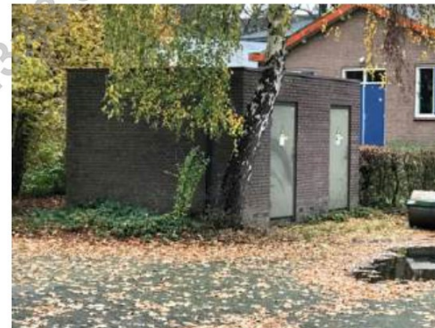
Gebouw nr.1: is een hoogspanningshuisje. Deze is opgebouwd uit een spouwmuur met een plat dak voorzien van dakleer. De spouwgaten zitten aan de onderzijde van het gebouw en zijn afgewerkt met roosters.
