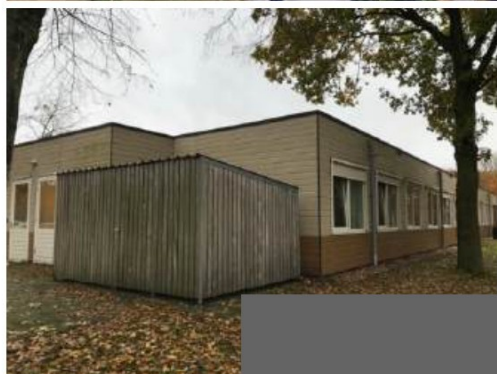
Gebouw nr. 103.A
