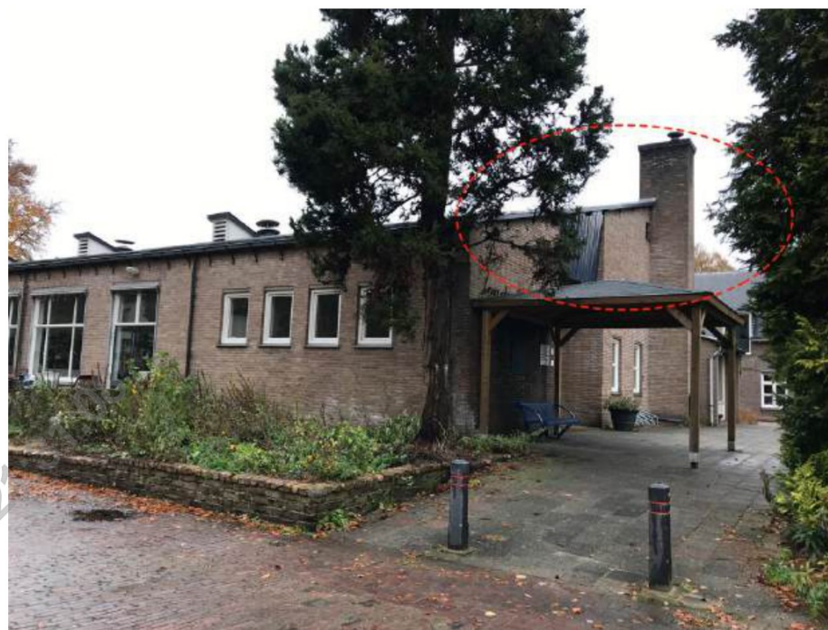
Foto 19. Zwermlocatie massa winterverblijfplaats gewone dwergvloermuis
