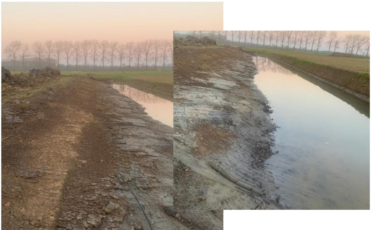
Figuur VI – Zuidelijke watergang, waarbij de watergang recent is gerealiseerd evenals het flauw talud. Deze watergang bestond nog niet.
