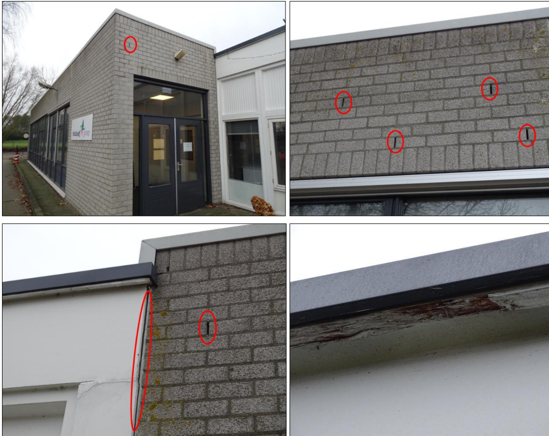
Foto's 7 t/m 10. Boven: Voorbeelden van geschikte openingen voor vleermuizen in het deel van het pand met grijze baksteen (1a), rood omcirkeld zijn voorbeelden van open stootvoegen; Linksonder: Open voeg, open stootvoeg (rood omcirkeld) en boeiiboord aan de noordzijde (overgang 1a en 1b); Rechtsonder: Opening in boeiiboord aan de noordzijde (1b).
