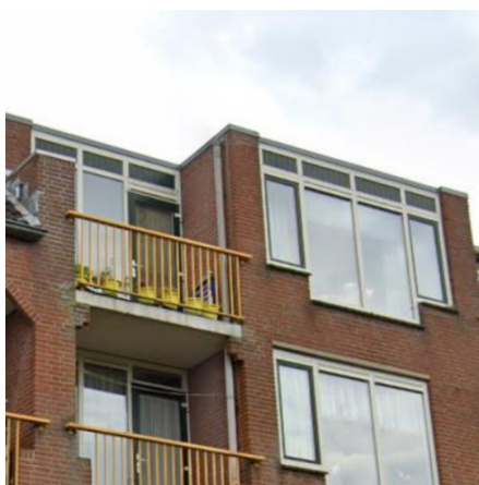
Foto 6: Kozijnen waarvan het glas wordt vervangen. Met daarboven de gevelpanelen.
