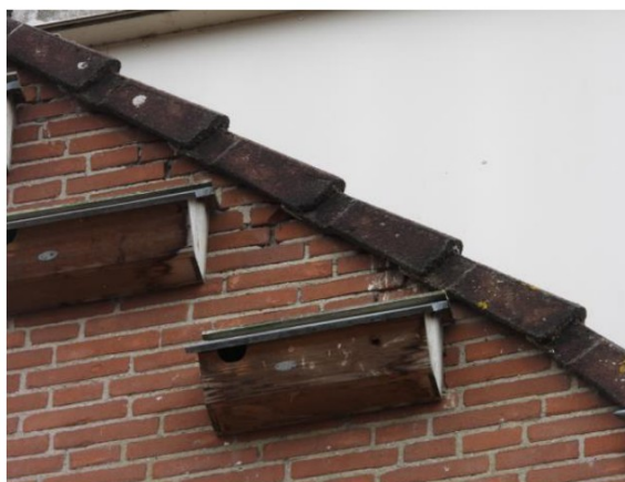
Foto 5: Detailfoto. Met zowel nestkast gierzwaluw als poepsporen op gevel op plekken met versleten metselwerk en beschadigde kantpannen.
