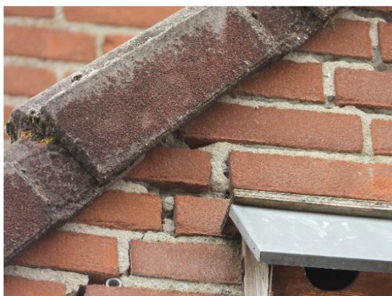
Foto 4: Detailfoto. Nestkast gierzwaluw. Muur met slijtage (naden en kieren tussen metselwerk en kantpannen).
