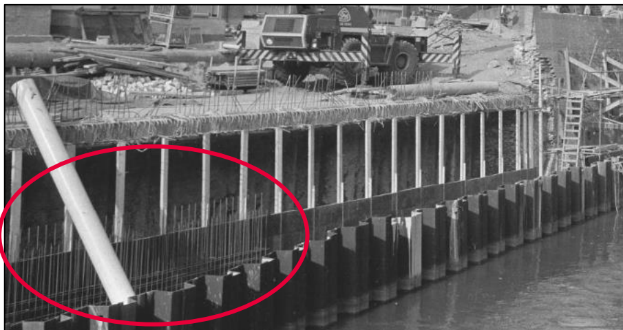
Figuur 4-22 Constructie kade (wapeningskorf rood omcirkeld) (verkregen van Brabants Historisch Informatie Centrum, identificatienummer 1907-003885, fotograaf 5.1.2.e)
