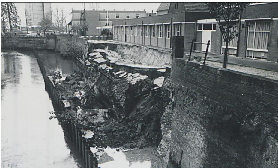
Figuur 4-19 Ingestorte kademuur Oude Haven (verkregen van Brabants Historisch Informatie Centrum, identificatienummer 1907-007552, fotograaf 5.1.2.e)
