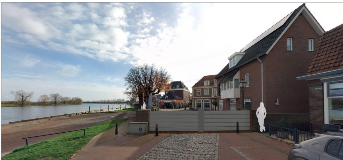
Figuur 7-19 Visualisatie van coupure Maaskade bij extreem hoogwater
