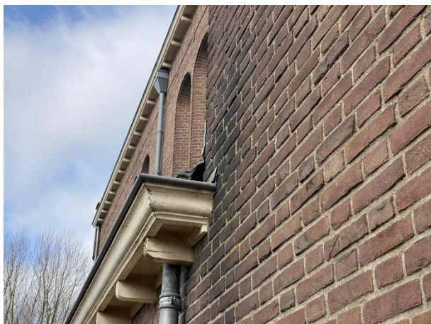
Foto 11: links, loshangende loodslab
