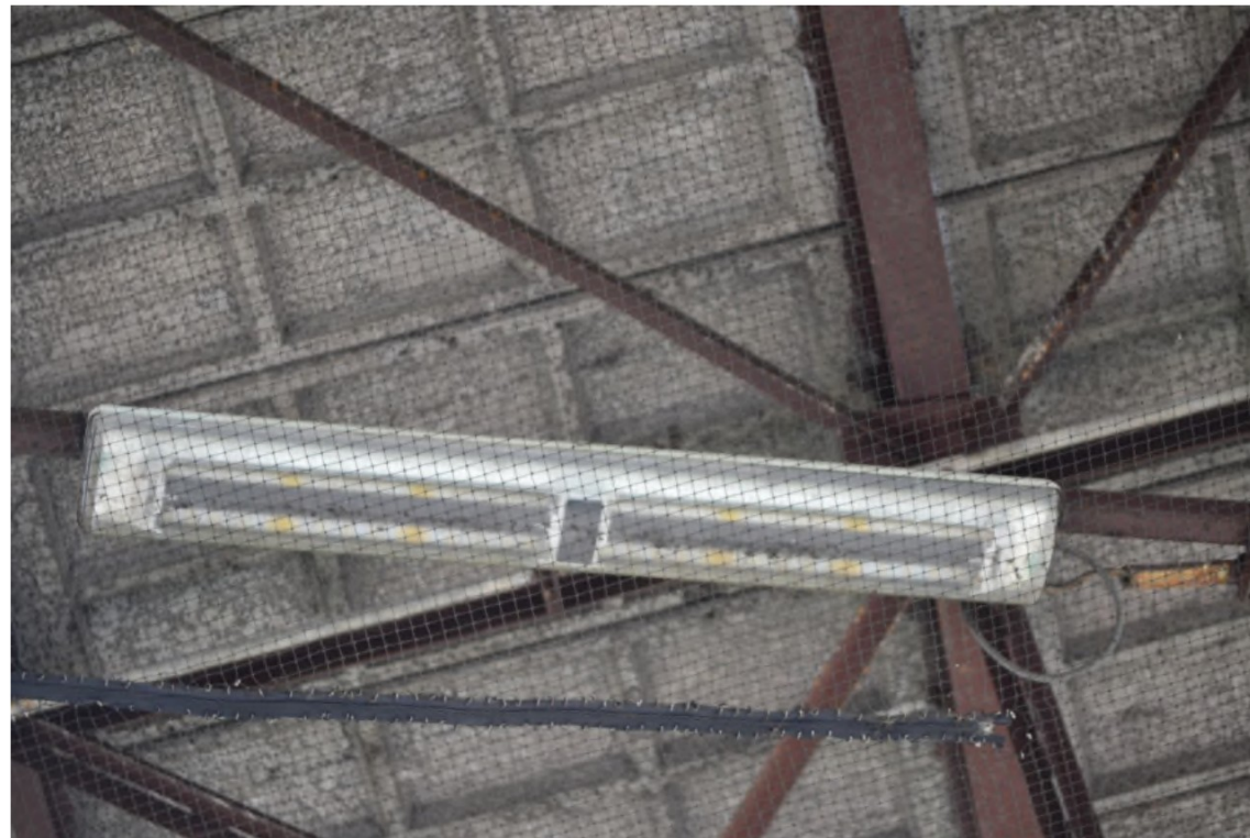
Duivenwerend net in dakoverkapping en ijzeren hekwerk tegen invliegen bij locatie Bargeloading
