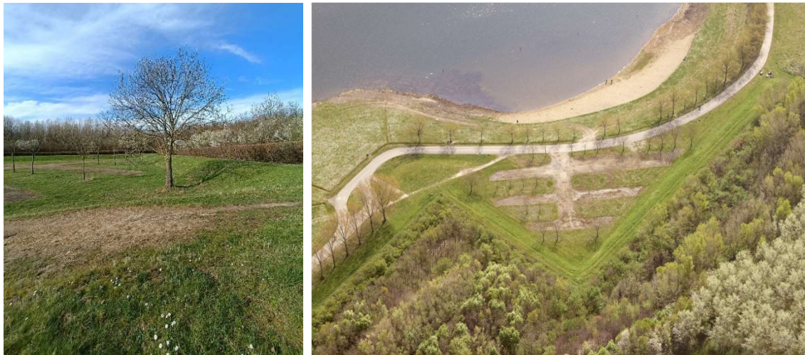
Figuur 4-5 Zigzag vormige dijk aan de Grote Hegge
