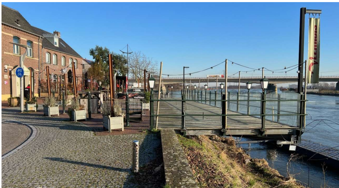
Figuur 4-31 Foto van de huidige situatie met het uitkragende terras. Op de voorgrond de keermuur.
