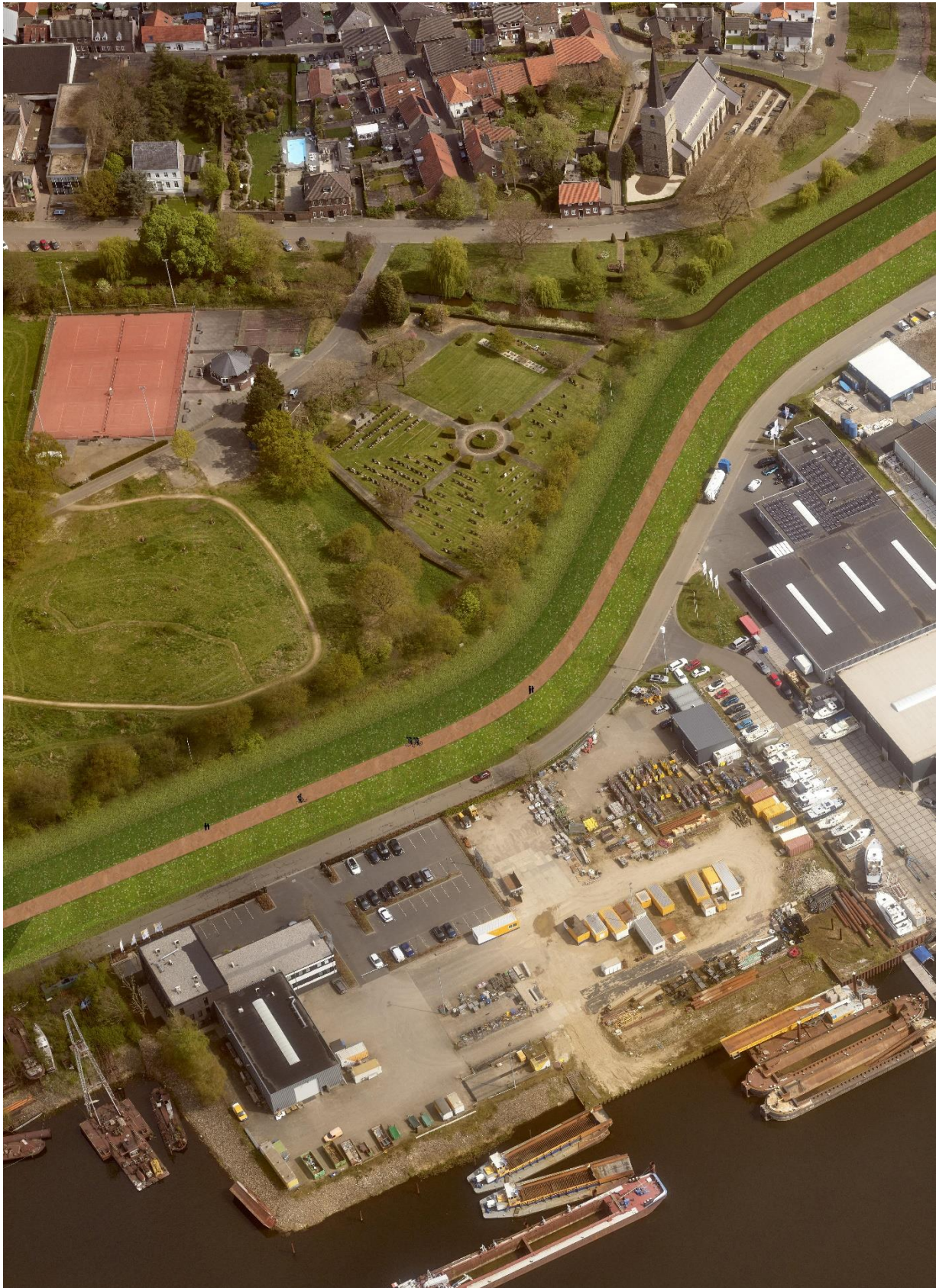
Figuur 4-44: Fietspad op de dijk dijksectie 3.
