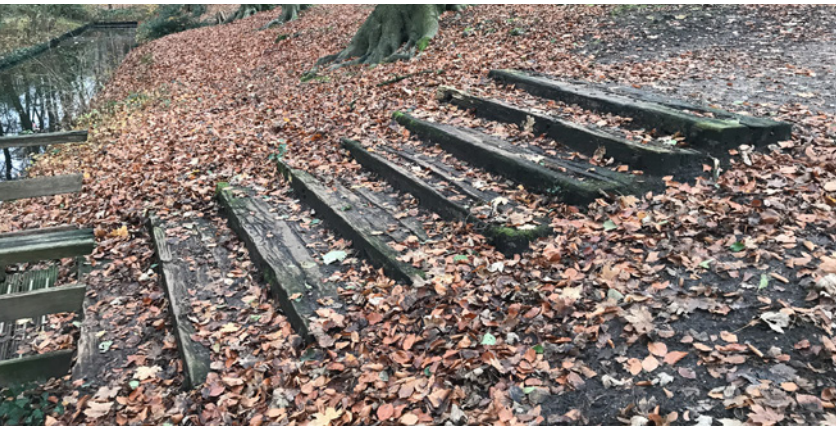
Trap van bielzen naar brug Vaarsloot is aan vervanging toe. Door de aanwezige boomwortels van monumentale beuken is het gewenst dat de trap van een zwevende constructie wordt gemaakt en de bodem hier zo min mogelijk geroerd wordt.
