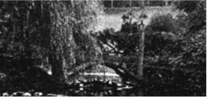
Brug over (inmiddels gedempte) uitloper vijver. De vormgeving verwijst naar de natuur. De takken zijn gemaakt van rank cementrustiek in een neutrale tint. Brug gaat op in de omgeving (foto uit begin 20e eeuw, Aschman, 2018).
