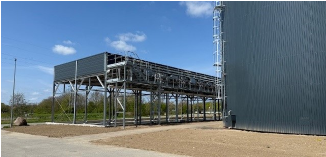
Voorbeeld van een opstelling van TEL in combinatie met een bovengrondse warmtebuffer (HTO-silo)
