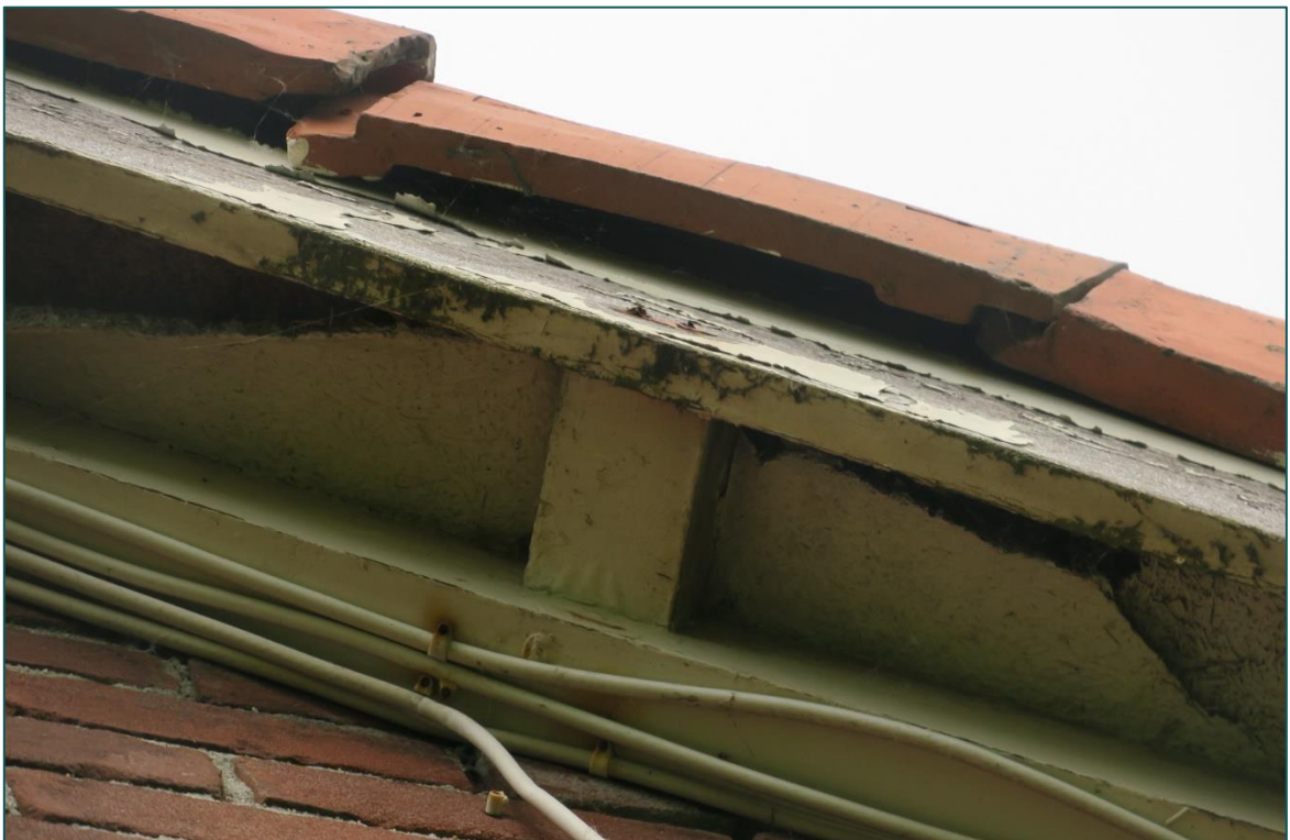
Figuur 3.3 Kierende dakpannen aan de kopgevels en ventilatiegaten aan de Boulevard de Wielingen 24 te Cadzand-Bad.
