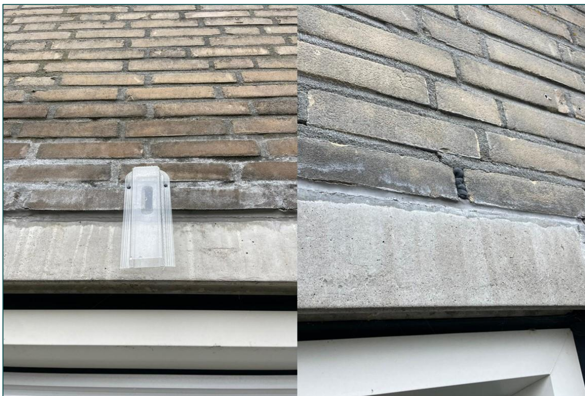
Figuur 2.1 De bebouwing kan ongeschikt gemaakt worden door gebruik te maken van exclusion flaps (links). Overige openingen kunnen afgedicht worden middels rugschuim/compriband (rechts).
