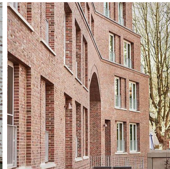
Gevelopeningen, kozijnen en negges: negges ((afgeschuinde) zijkant van de muur opening aan de buitenzijde van het kozijn) zijn minstens 190mm diep. Deze neggediepte mag stapsgewijs opgezocht worden
