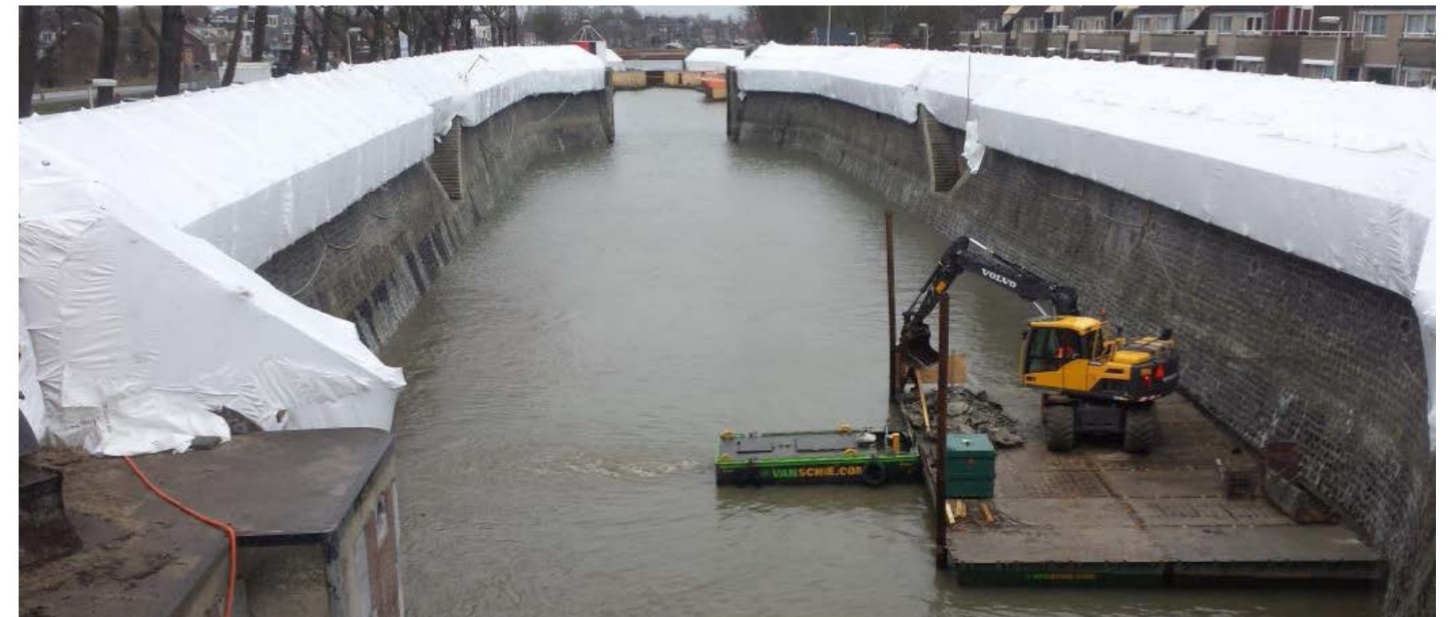
uitvoeringsmethode herstel kolkwanden Koninginnensluis (2017)
