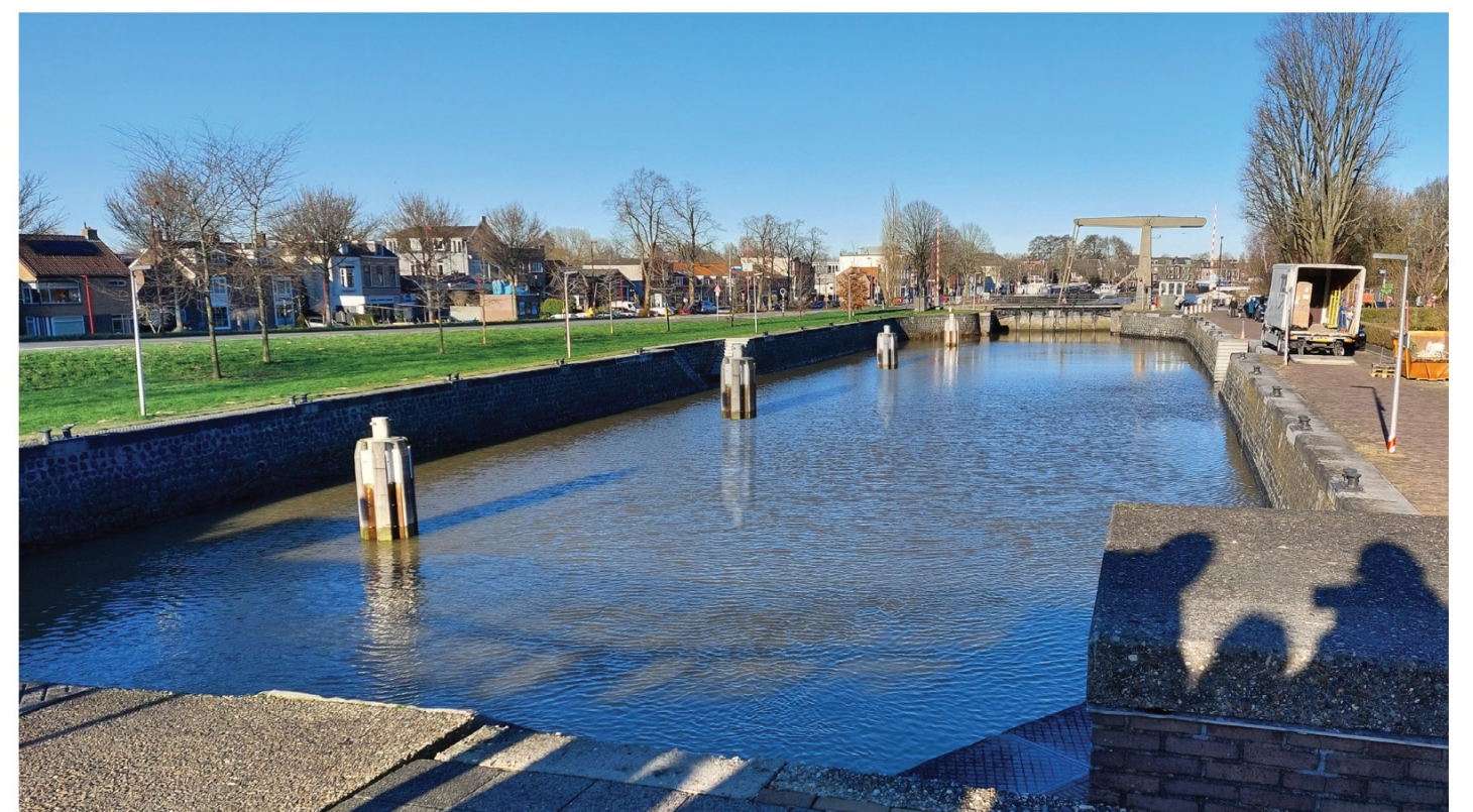
beeld van sluiscolk in huidige toestand en met twee aanvullende meerpalen
