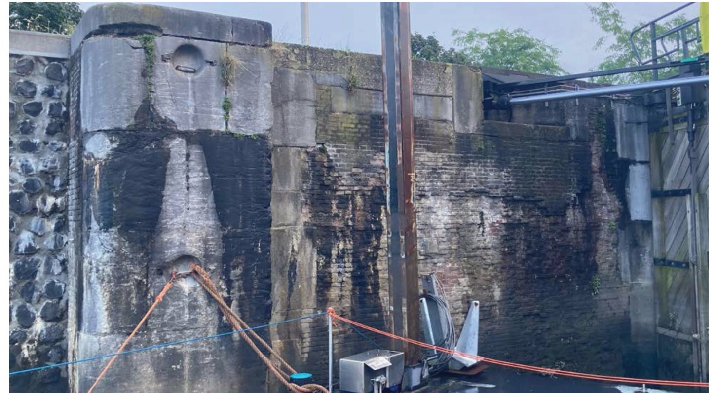
baksteen metselwerk + natuursteen sluishoofd midden
