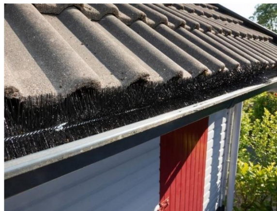
Figuur 8.6 Voorbeeld van toepassen spouwborstels in dakgoot.
