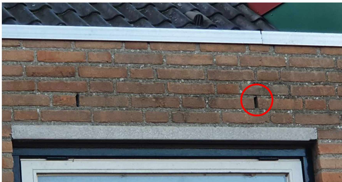
Figuur 4 Open stootvoeg boven raam die gebruikt wordt als toegang tot de zomerverblijfplaats door de gewone dwergvleermuis.
