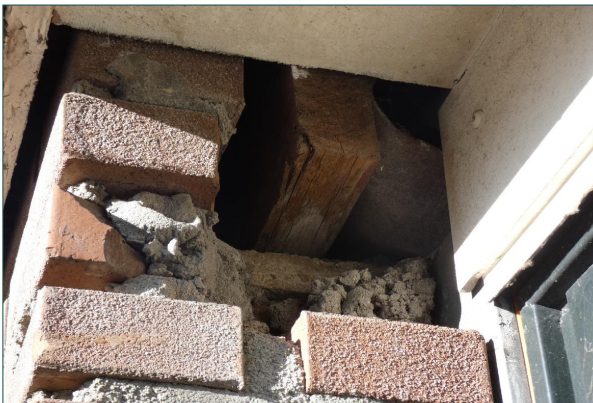
Figuur 3.2 Gat in de buitenmuur van de garagebox, waardoor vleermuizen in de spouwmuur kunnen komen.
