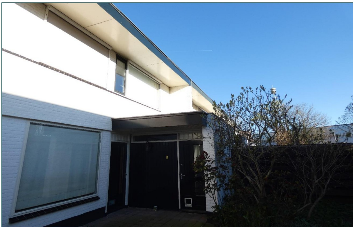
Figuur 2 De woningen bestaan uit bakstenen muren en een plat bitumen dak.
