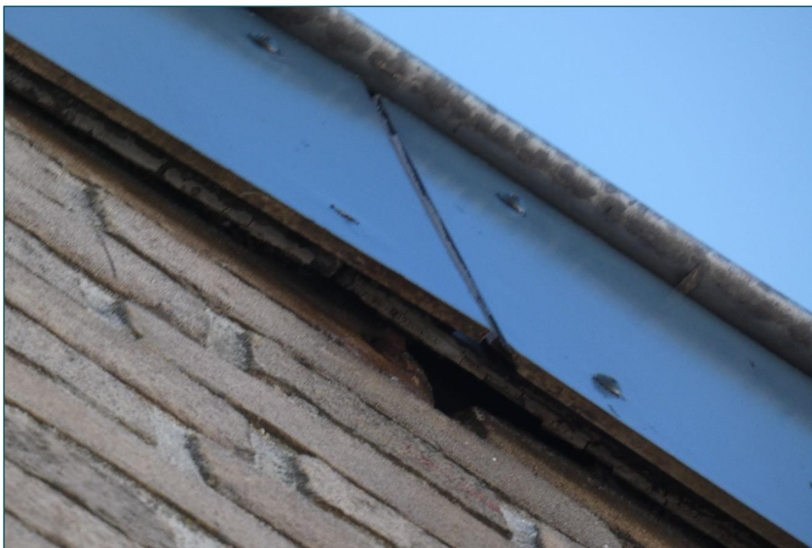
Figuur 3.1 Ruimte tussen de bakstenenmuur en het boeibord biedt vleermuizen toegang tot de spouwmuur.
