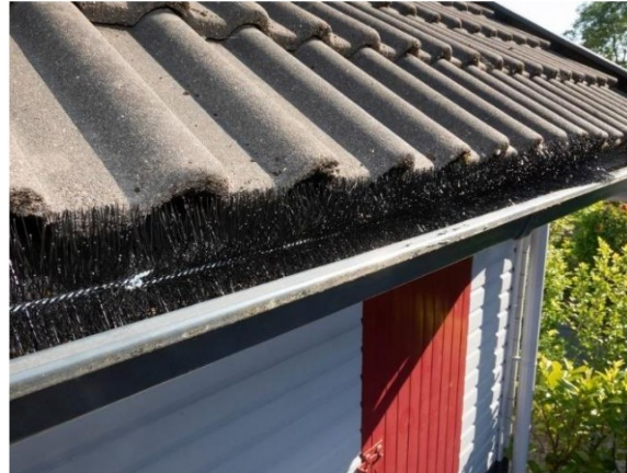
Figuur 8.4 Voorbeeld van toepassen spouwborstels in dakgoot.
