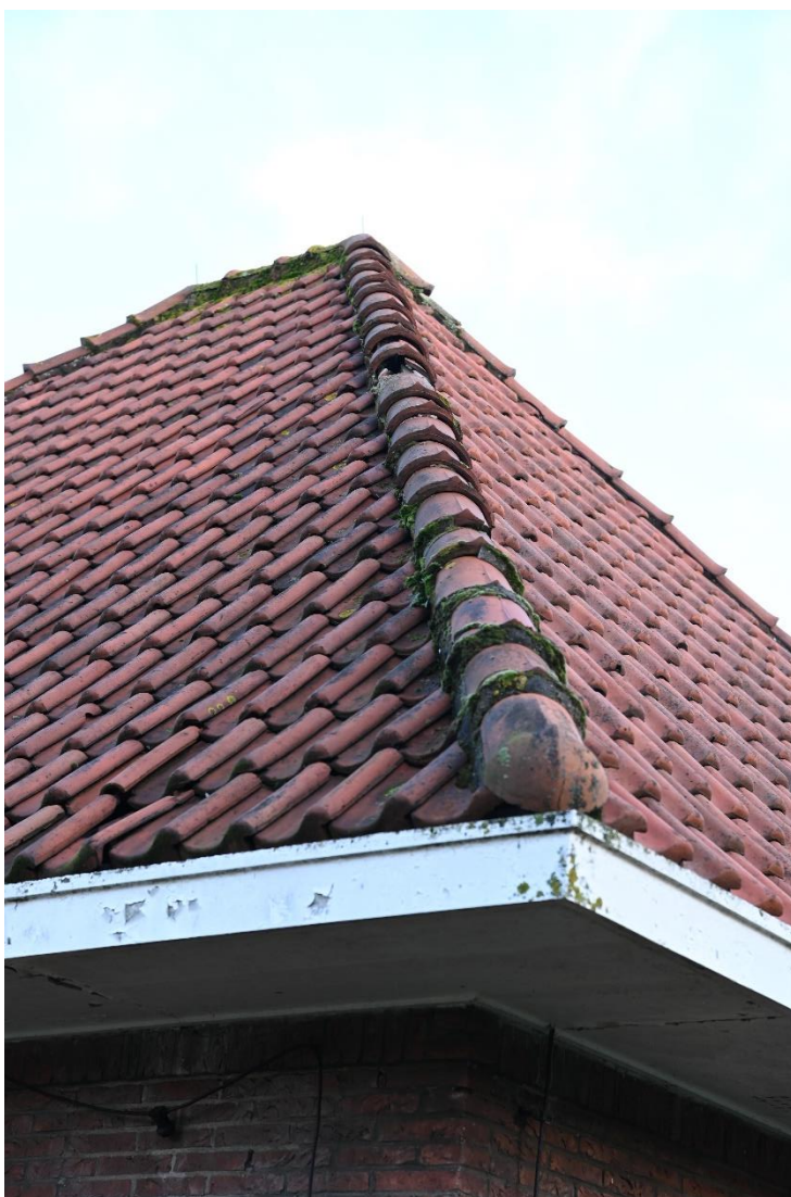
Afbeelding 10: Het dak van de opstal is bedekt met dakpannen. Deze pannen rusten op een betonnen dakconstructie. Op enkele plekken dit door verweer losgeraakt en kunnen dieren onder de pannen kruipen. Tijdens de inspectie zijn er geen sporen van dieren en nestmateriaal in deze ruimten aangetroffen.
