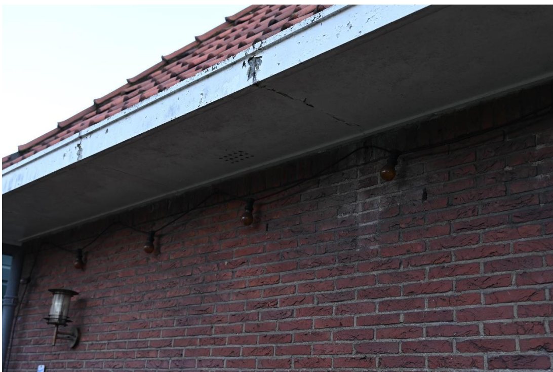
Afbeelding 7: Opname van de opstal aanwezig op het studiegebied. Deze beschikt over een gemetselde muur met stootvoegen die in contact staan met een ongeïsoleerde spouwruimte. Er is een dakoverstek aanwezig die nauw aansluit met de muur. Hier zijn geen openingen aangetroffen. Het dak is bedekt met dakpannen.
