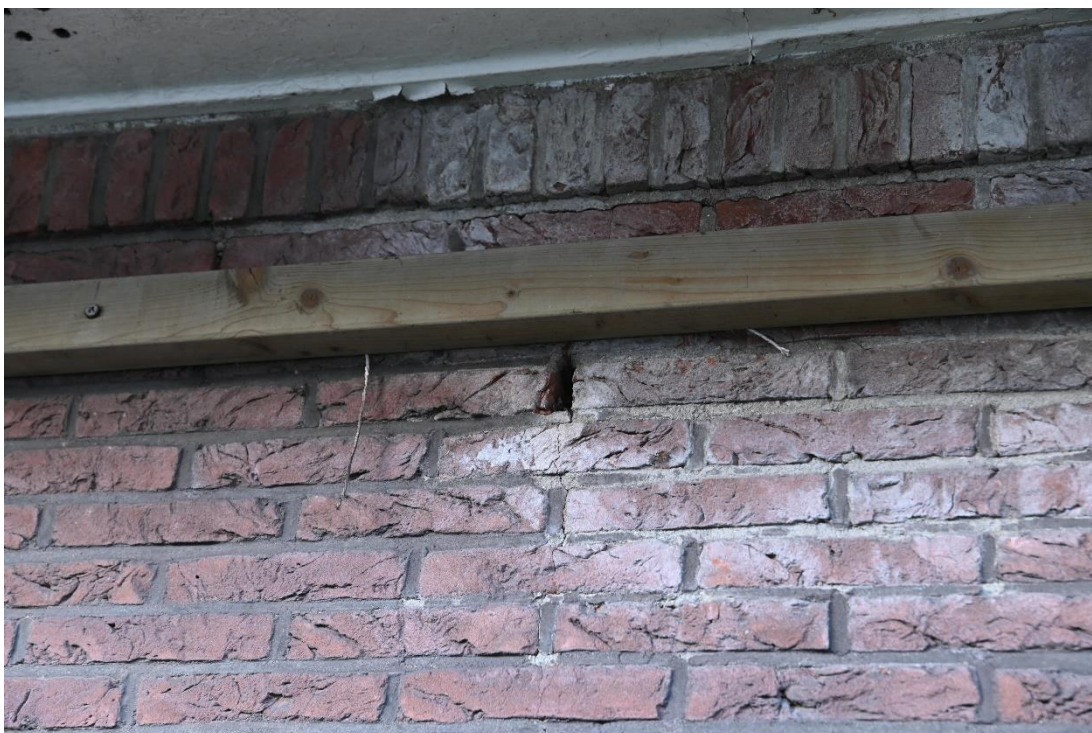
Afbeelding 8: Stootvoeg in de muur van de opstal. Aan de bovenzijde is de dakoverstek zichtbaar.
