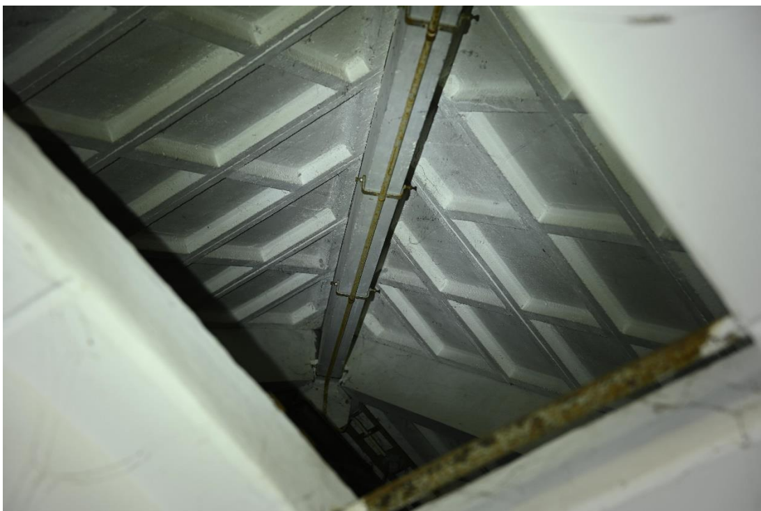
Afbeelding 11: De betonnen dakconstructie vanaf de binnenzijde (onderzijde) bekeken. De betonplaten sluiten naadloos aan en er zijn geen openingen aangetroffen. Dieren kunnen via het dak derhalve de binnenzijde van de opstal niet bereiken. Ook zijn hier geen sporen van dieren aangetroffen.
