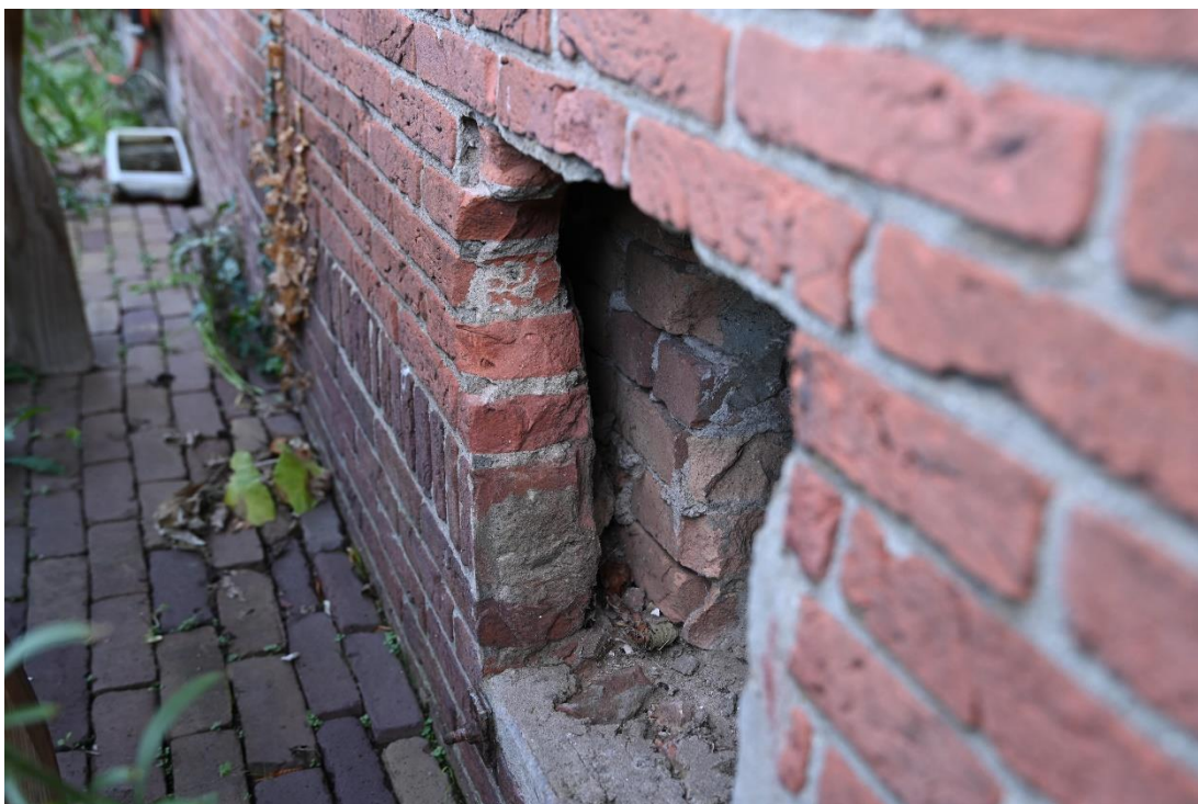
Afbeelding 9: Opening in de buitenmuur. De ongeïsoleerde spouwmuur is zichtbaar.
