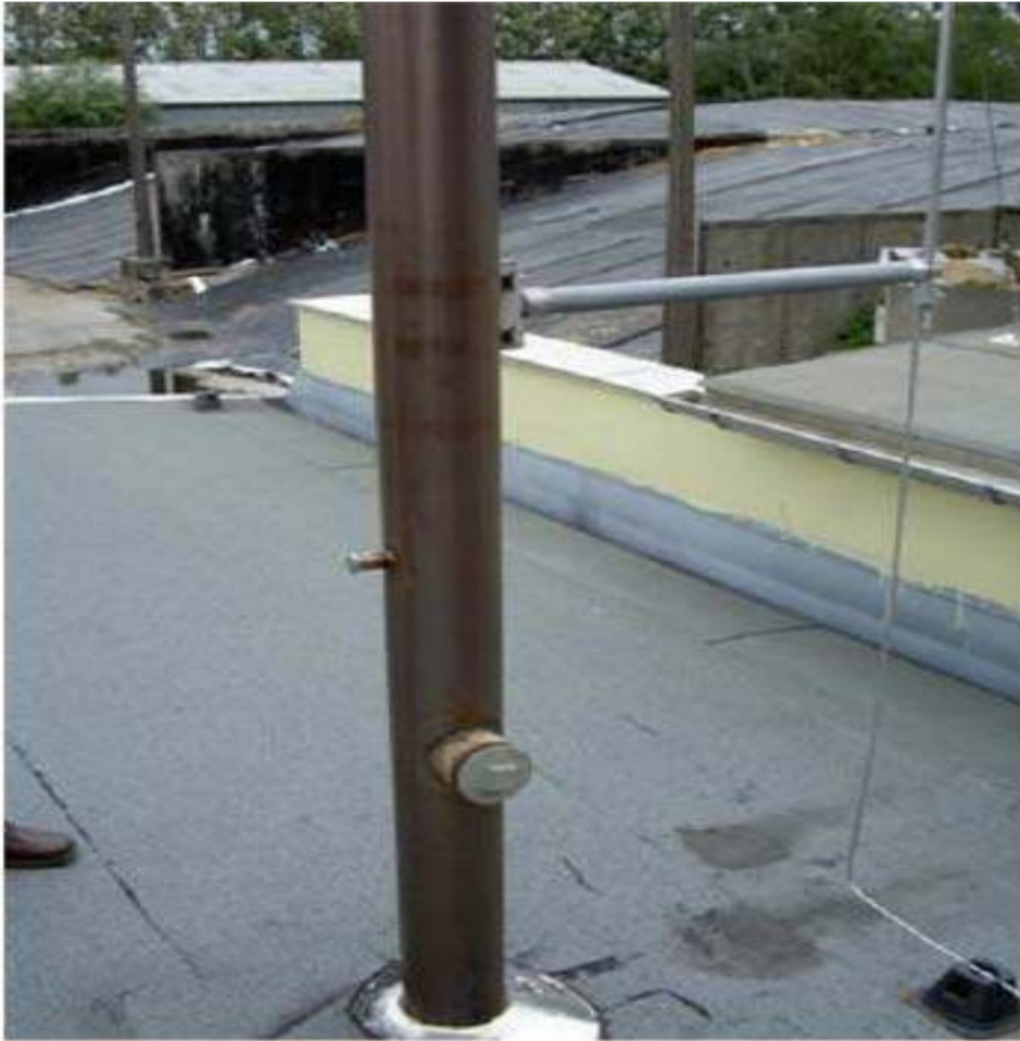
Abbildung 3: Messstelle am BHKW 1/1
