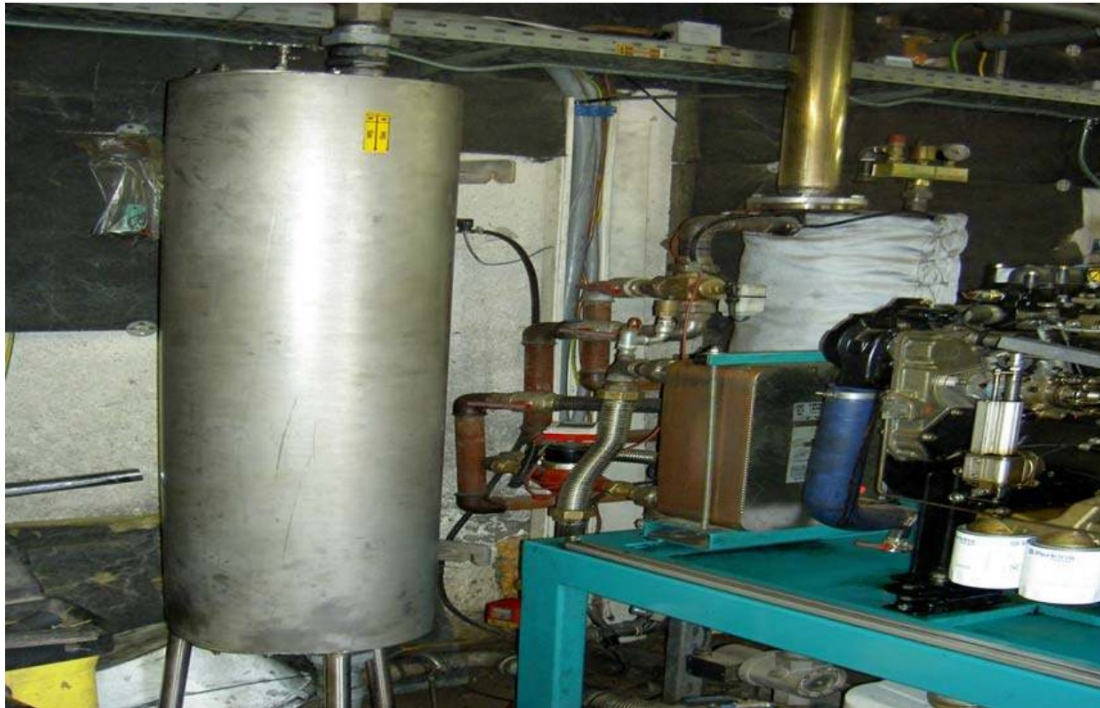
Abbildung 4: Aktivkohlefilter am BHKW 15/1
