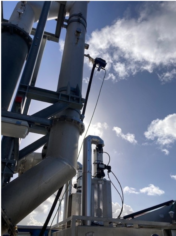
Foto 3.1. Meetlocatie in schoorsteen RTO.
