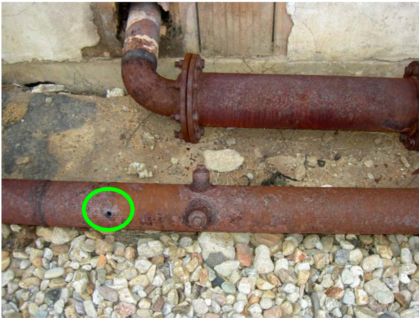
Abbildung 7: Messstelle am BHKW 9/3
