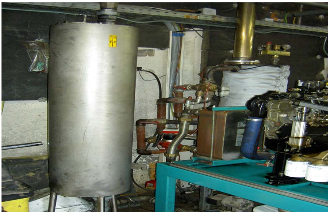
Abbildung 4: Aktivkohlefilter am BHKW 15/1
