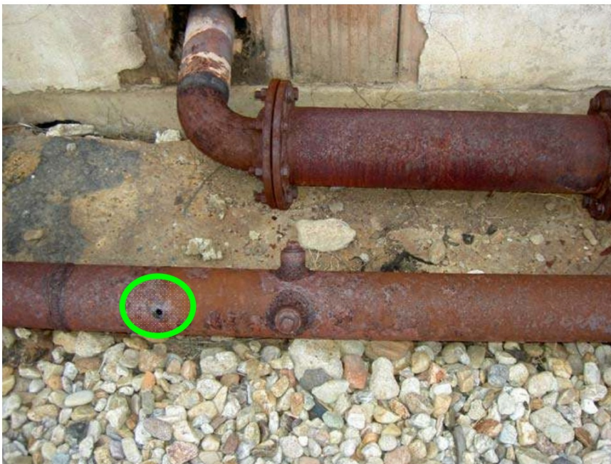
Abbildung 7: Messstelle am BHKW 9/3
