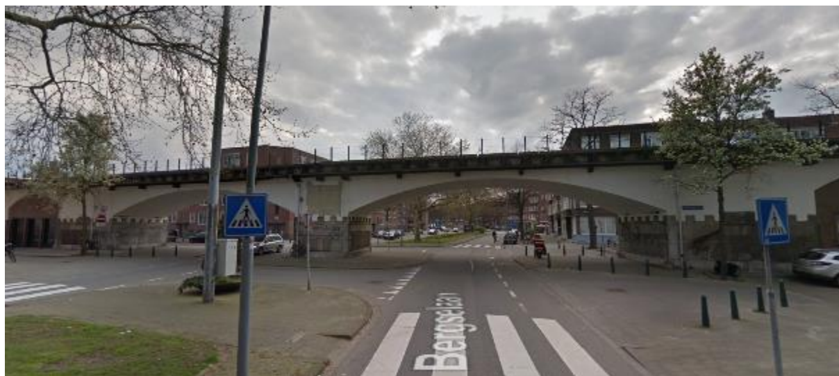
Figuur 4.14: Vooraanzicht op viaduct Bergselaan
