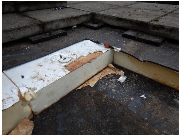
Foto 4.16: Opbouw afwerking perron oostzijde.
