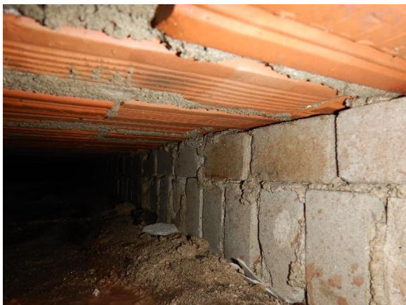
Foto 4.12: Ruimte onder holle baksteenvloer.
