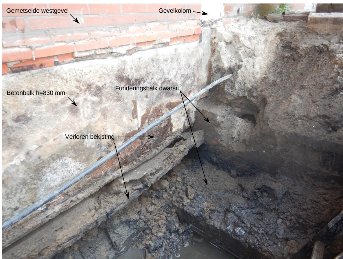
Foto 4.1: Overzicht vrijgemaakte betonbalk onder metselwerk westgevel.
