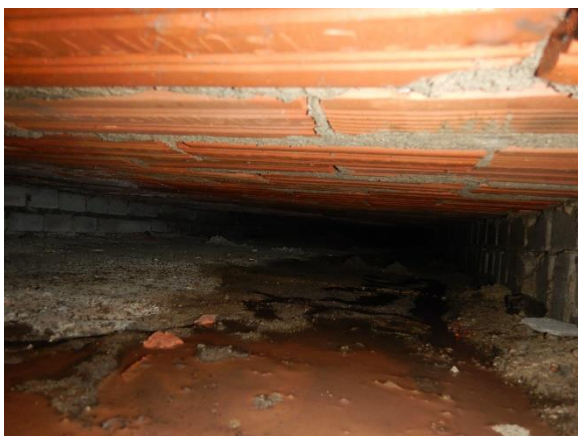
Foto 4.14: Ruimte onder holle baksteenvloer.
