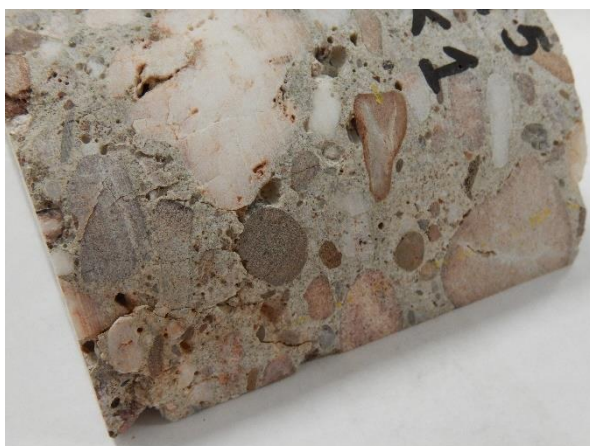
Foto 3.15: Betonkern K1 – Locatie 2 (buitenzijde, na drukproef).
