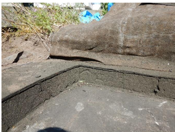
Foto 3.3: Locatie 3 – Foamglas isolatie en waterdichte afwerking.
