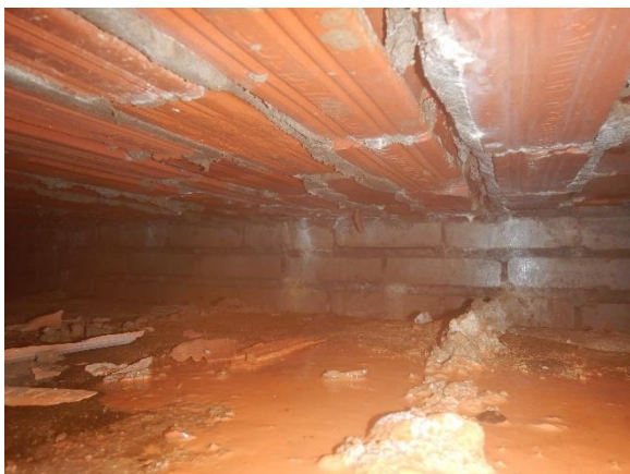
Foto 4.19: Ruimte onder holle baksteenvloer.
