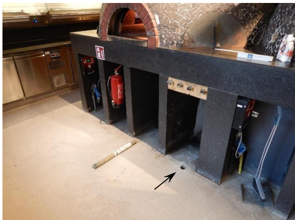
Foto 4.7: Overzicht boorlocatie boog 96.
