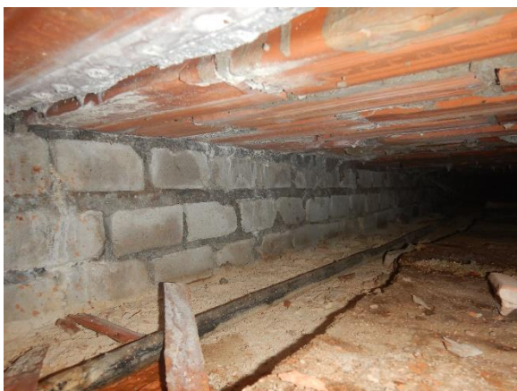
Foto 4.17: Ruimte onder holle baksteenvloer.
