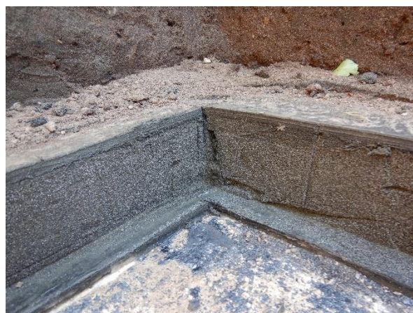
Foto 3.4: Locatie 4 – Foamglas isolatie en waterdichte afwerking.
