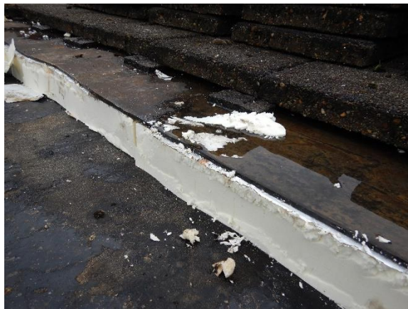
Foto 4.11: Opbouw afwerking perron westzijde.
