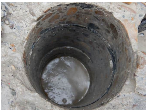
Foto 6.41: Boorgat prefab randbalk oostfase.
