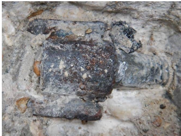
Foto 6.74: Vrijgemaakte lasbusbevestiging pre-fab console onderzoekslocatie O13-W3.
