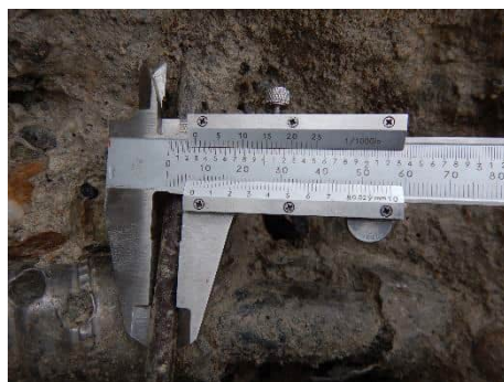
Foto 6.60: Diameter 1 e laag (Ø8 mm).
