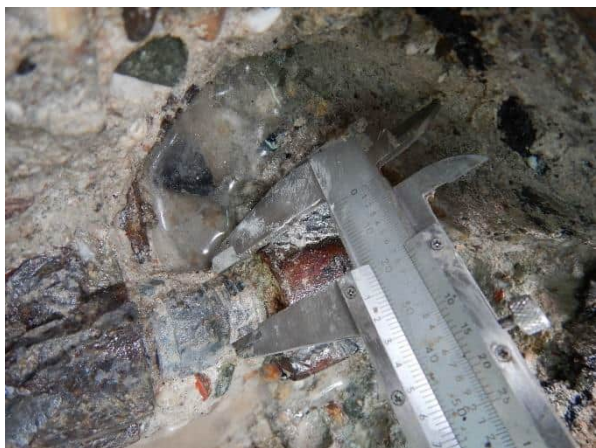
Foto 4.15: Diameter draadeind (Ø20 mm).
