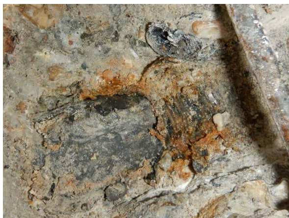
Foto 6.89: Vrijgemaakte wartelconstructie Dywidagstaaf onderzoekslocatie O15-W4.
