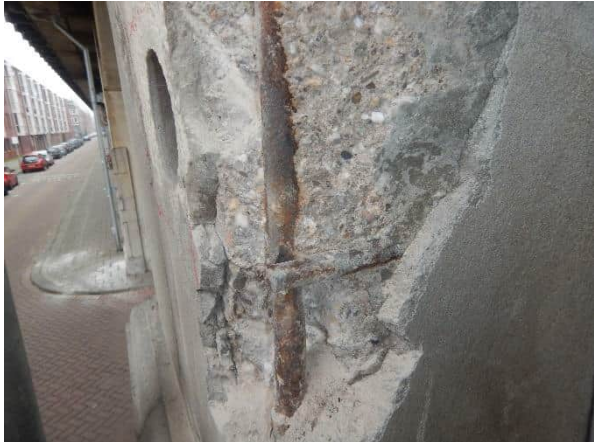
Foto 6.30: Hoofdwapening kolom en verdeelwapening stabiliteitswand.
