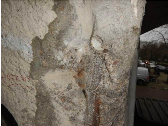
Foto 6.31: Hoofd- en beugelwapening kolom.
