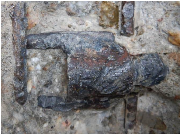
Foto 6.73: Vrijgemaakte lasbusbevestiging pre-fab console onderzoekslocatie O13-W1.
