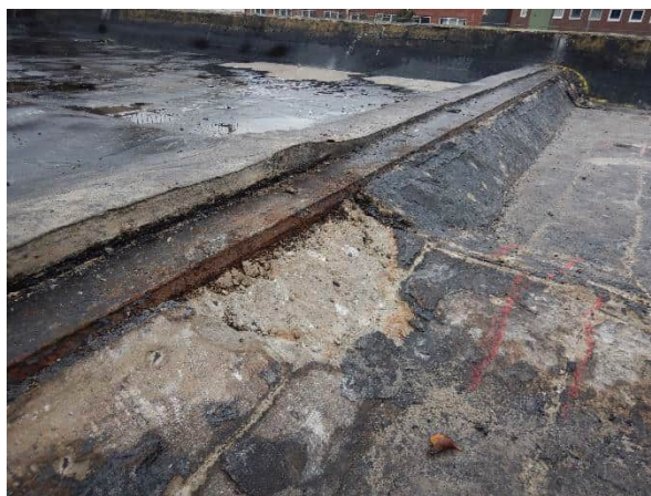
Foto 6.50: Stalen dwarsdrager in betondek.
