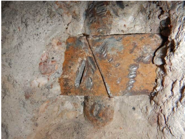
Foto 6.36: Hoofd- en beugelwapening kolom.
