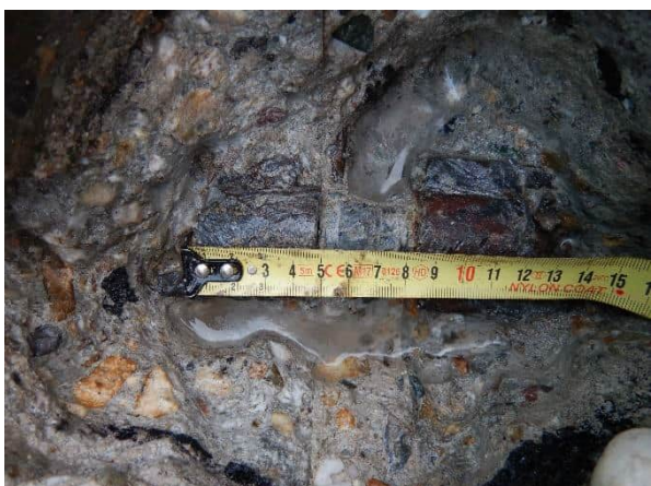
Foto 4.13: Lengte lasbus (± 4 cm).
