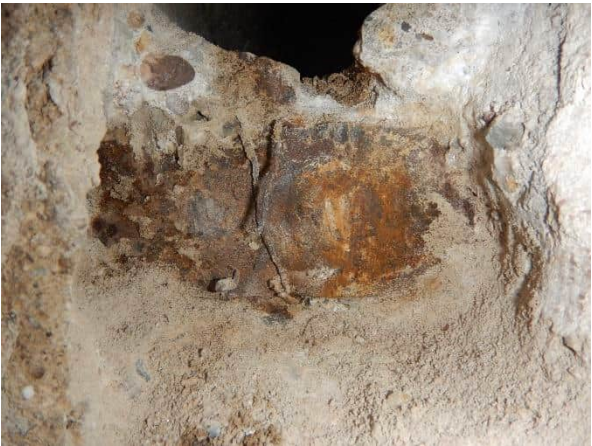
Foto 6.29: Hoofd- en beugelwapening wand kolom.
