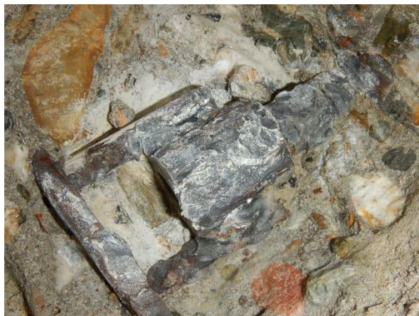
Foto 6.78: Vrijgemaakte lasbusbevestiging pre-fab console onderzoekslocatie O16-W6.
