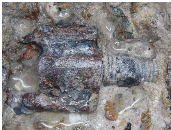
Foto 6.84: Vrijgemaakte lasbusbevestiging pre-fab console onderzoekslocatie O20-W6.
