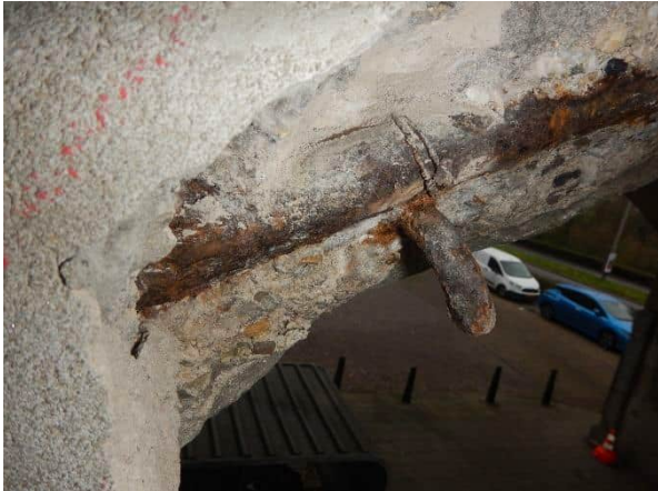
Foto 6.32: Hoofdwapening onder randbalk.
