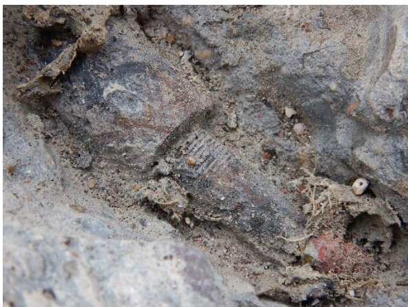
Foto 6.94: Vrijgemaakte wartelconstructie Dywidagstaaf onderzoekslocatie O19-W3.
