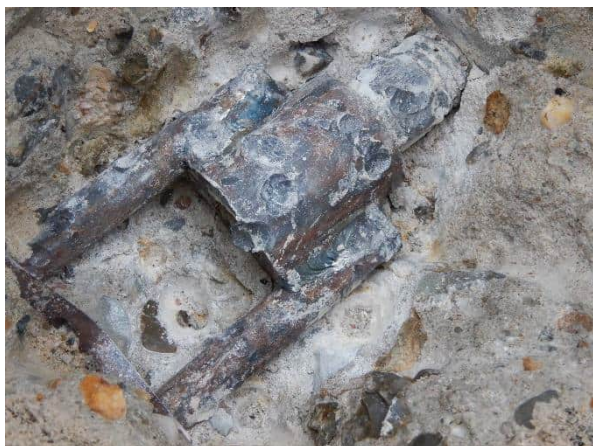
Foto 6.81: Vrijgemaakte lasbusbevestiging pre-fab console onderzoekslocatie O19-W1.
