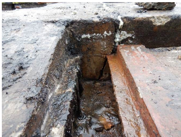
Foto 4.19: Dilatatie westfase onderzoekslocatie O15, na aanvullend sloopwerk.
