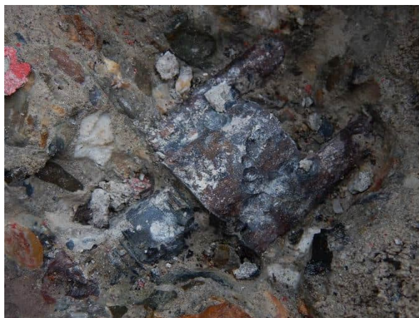
Foto 6.82: Vrijgemaakte lasbusbevestiging pre-fab console onderzoekslocatie O19-W6.
