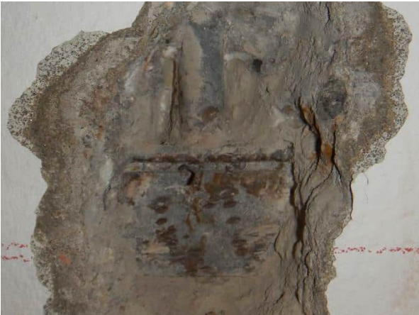
Foto 6.21: Hoofd- en beugelwapening kolom.
