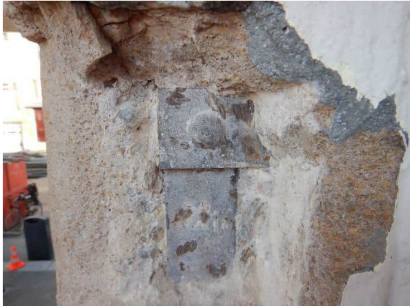
Foto 6.24: Hoofd- en beugelwapening kolom.
