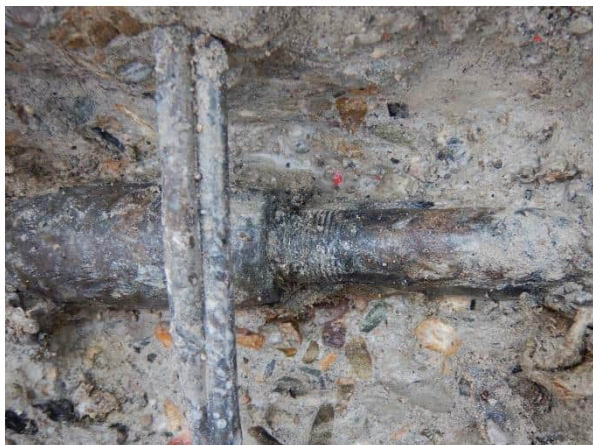
Foto 6.85: Vrijgemaakte wartelconstructie Dywidagstaaf onderzoekslocatie O13-W2.
