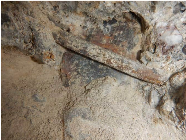
Foto 6.35: Flank- en beugelwapening randbalk.
