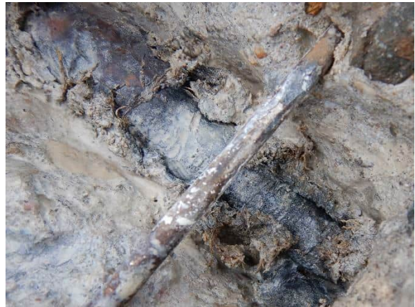
Foto 6.91: Vrijgemaakte wartelconstructie Dywidagstaaf onderzoekslocatie O16-W4.
