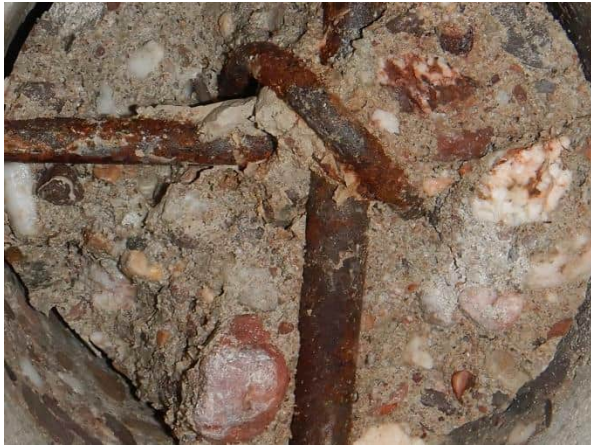
Foto 6.37: Onderwapening getoogde vloer.
