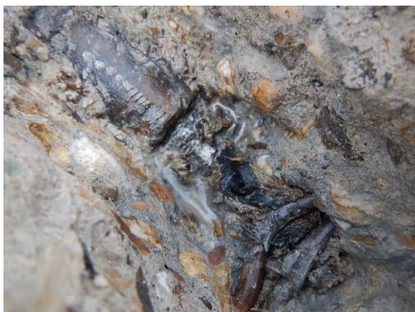
Foto 6.86: Vrijgemaakte wartelconstructie Dywidagstaaf onderzoekslocatie O14-W3.
