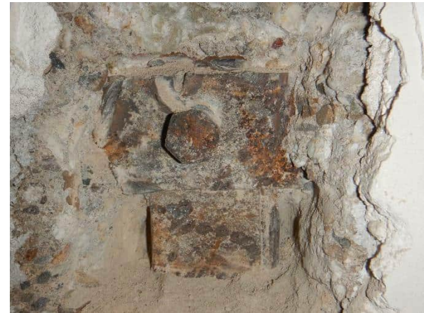
Foto 6.19: Hoofd- en beugelwapening kolom.
