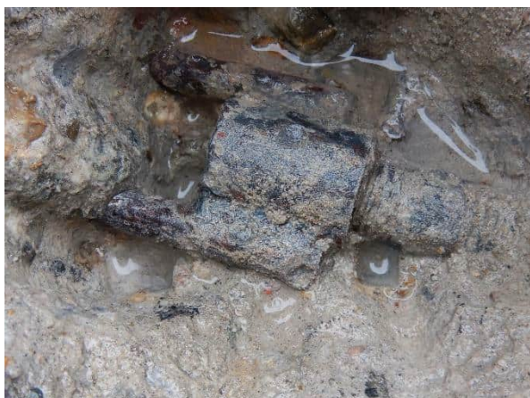
Foto 6.83: Vrijgemaakte lasbusbevestiging pre-fab console onderzoekslocatie O20-W1.
