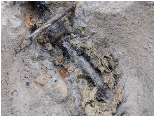
Foto 6.96: Vrijgemaakte wortelconstructie Dywidagstaaf onderzoekslocatie O20-W3.
