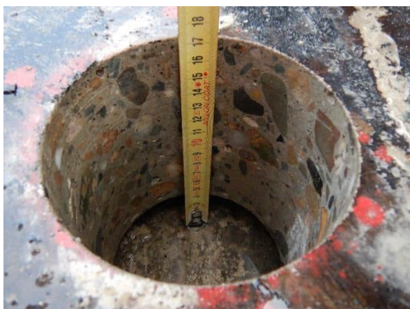
Foto 6.51: Boorgat prefab randbalk oostfase; holle ruimte onder prefab randbalk.
