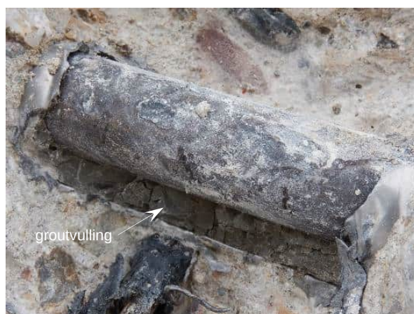
Foto 4.10: Groutvulling koker dwarsvoorspanning.
