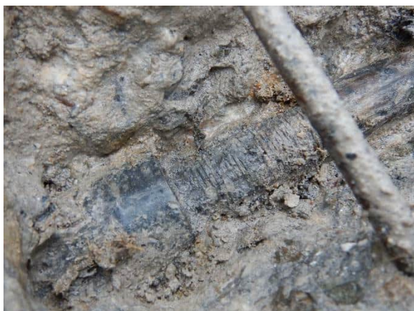
Foto 6.88: Vrijgemaakte wartelconstructie Dywidagstaaf onderzoekslocatie O15-W3.
