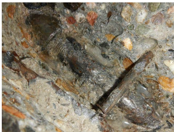
Foto 6.87: Vrijgemaakte wartelconstructie Dywidagstaaf onderzoekslocatie O14-W4.
