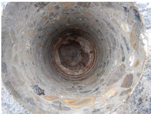
Foto 6.47: Boorgat in-situ betondek westfase; Celotex isolatieplaat zichtbaar.
