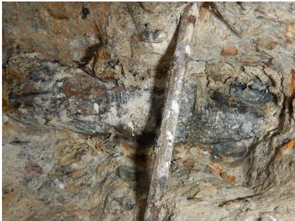
Foto 6.90: Vrijgemaakte wartelconstructie Dywidagstaaf onderzoekslocatie O16-W3.
