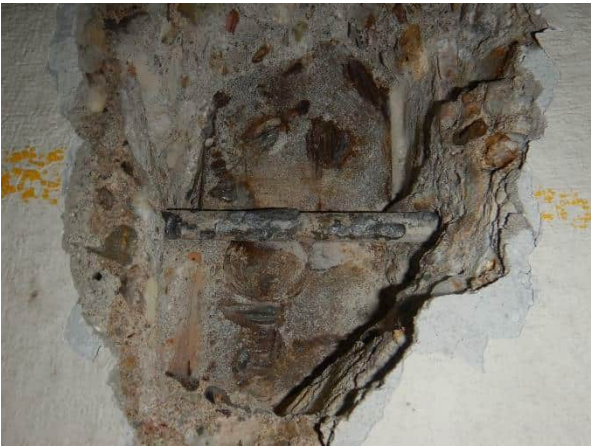
Foto 6.20: Wapening ondervloer en balk.
