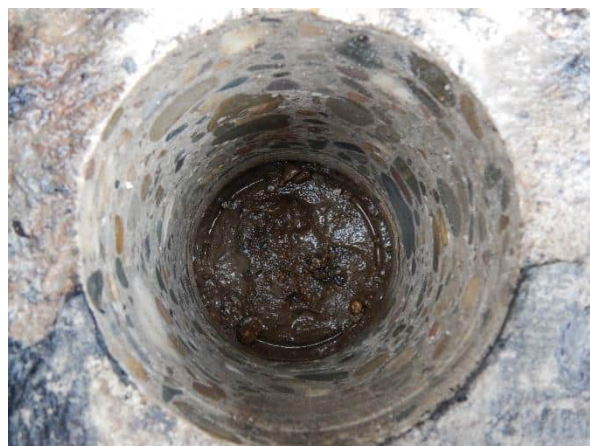
Foto 6.42: Boorgat prefab randbalk westfase.
