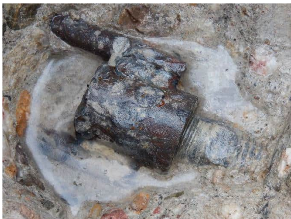
Foto 6.79: Vrijgemaakte lasbusbevestiging pre-fab console onderzoekslocatie O18-W1.
