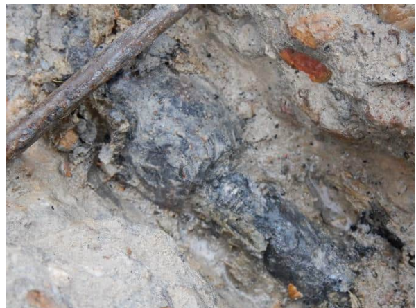
Foto 6.93: Vrijgemaakte wartelconstructie Dywidagstaaf onderzoekslocatie O18-W4.
