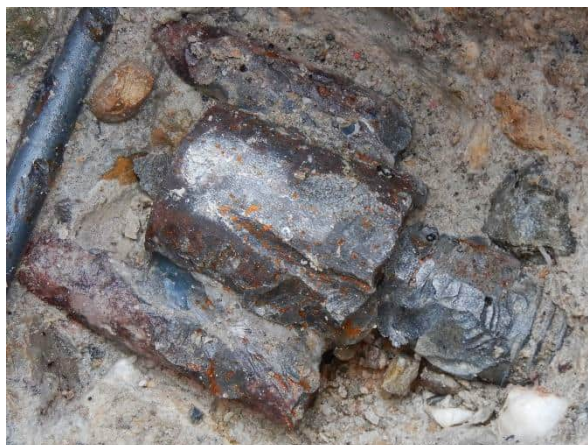
Foto 6.80: Vrijgemaakte lasbusbevestiging pre-fab console onderzoekslocatie O18-W6.
