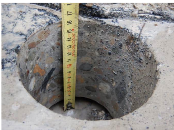
Foto 6.43: Boorgat prefab randbalk oostfase; holle ruimte onder prefab randbalk.
