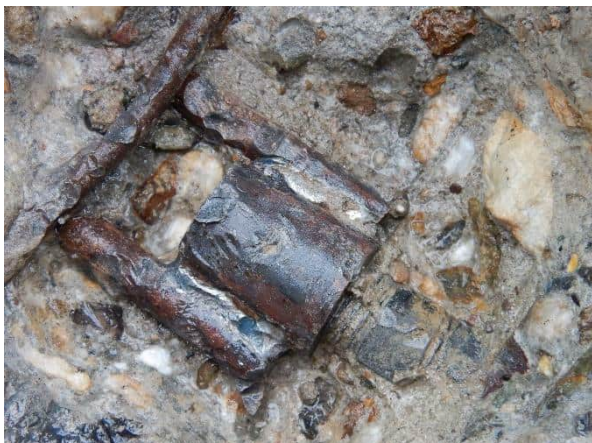
Foto 6.75: Vrijgemaakte lasbusbevestiging pre-fab console onderzoekslocatie O14-W1.
