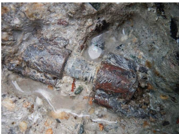
Foto 4.11: Overzicht vrijgemaakte lasbusbevestiging prefab consoles.
