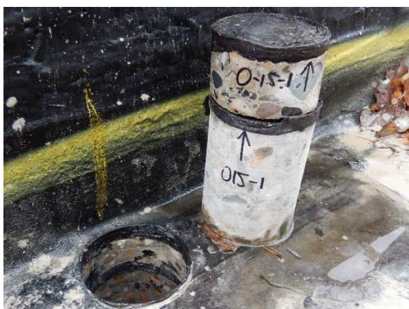
Foto 6.45: Betonkern ongewapende deklaag en prefab randbalk oostfase.
