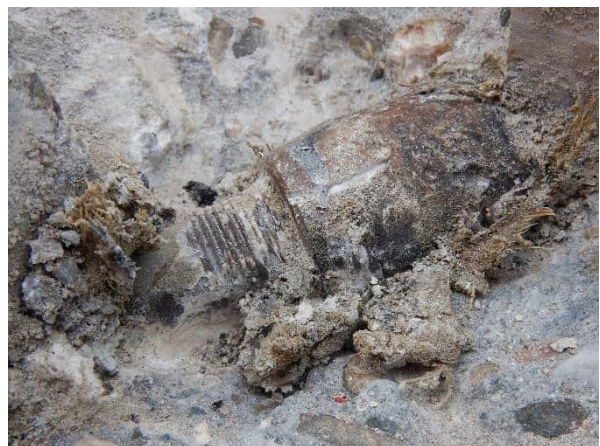
Foto 6.95: Vrijgemaakte wartelconstructie Dywidagstaaf onderzoekslocatie O19-W4.
