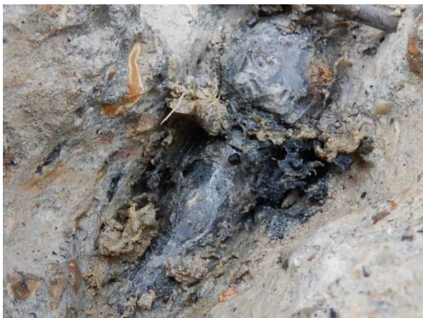
Foto 6.92: Vrijgemaakte wartelconstructie Dywidagstaaf onderzoekslocatie O18-W3.
