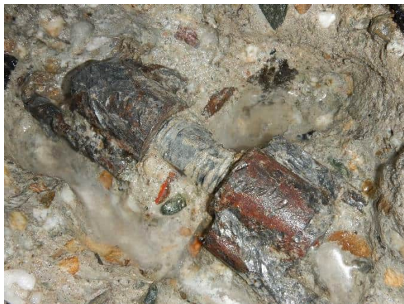
Foto 6.76: Vrijgemaakte lasbusbevestiging pre-fab console onderzoekslocatie O14-W6.
