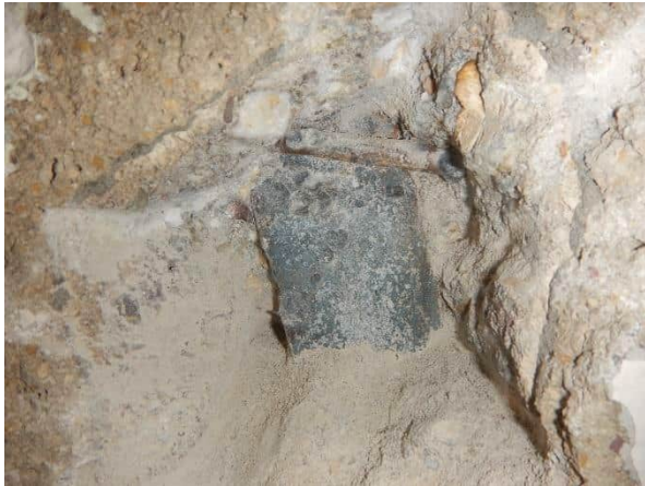
Foto 6.34: Flank- en beugelwapening randbalk.
