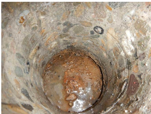
Foto 6.55: Boorgat in-situ betondek oostfase; Celotex isolatieplaat zichtbaar.
