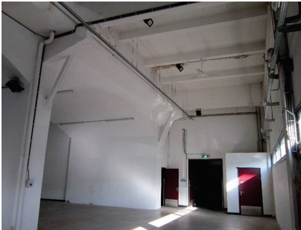
Figuur 2.11: Binnenzijde hal (oude inspectiefoto)
