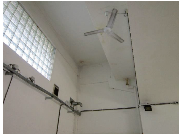
Figuur 2.12: Binnenzijde hal (oude inspectiefoto)
