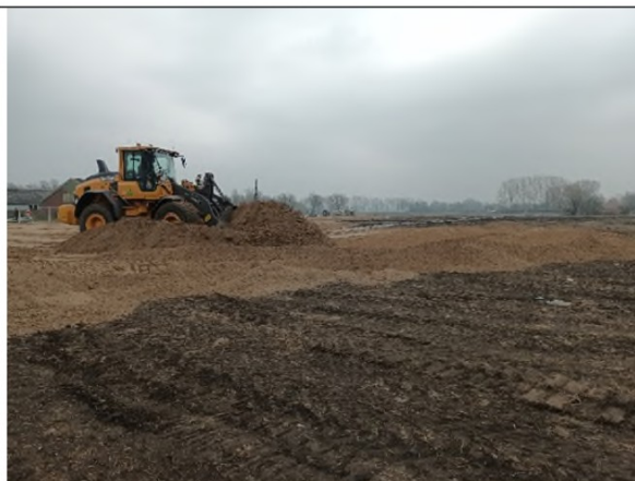
Aanbrengen signaallaag, duidelijk kleurcontrast met de ondergrond zichtbaar
