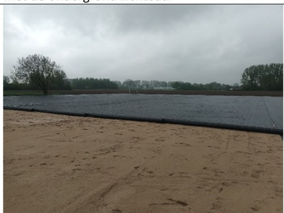
Aanbrengen geotextiel op signaallaag
