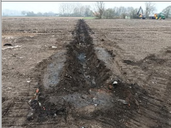
Graven centrale kabelsleuf
