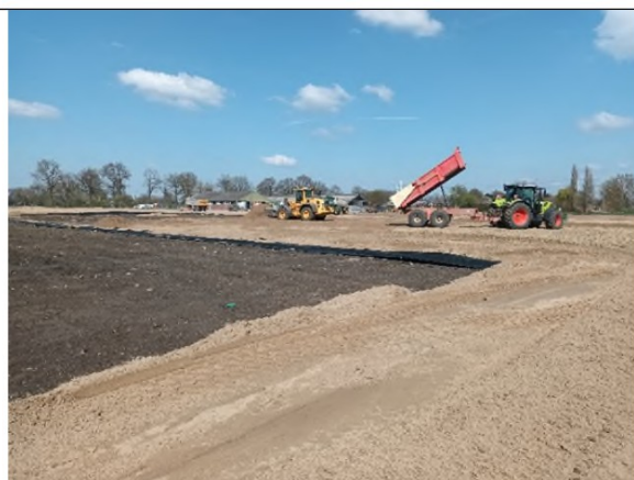
Aanbrengen signaallaag
