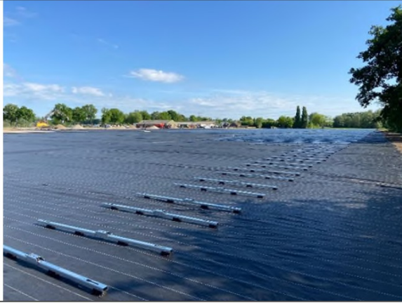
Geotextiel aanbrengen
