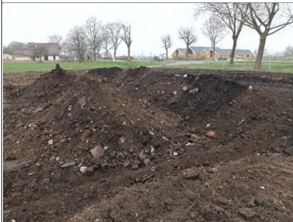
Herschikken stortmateriaal in lagere delen
