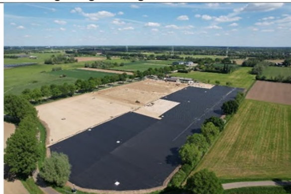
Luchtfoto signaallaag en geotextiel
